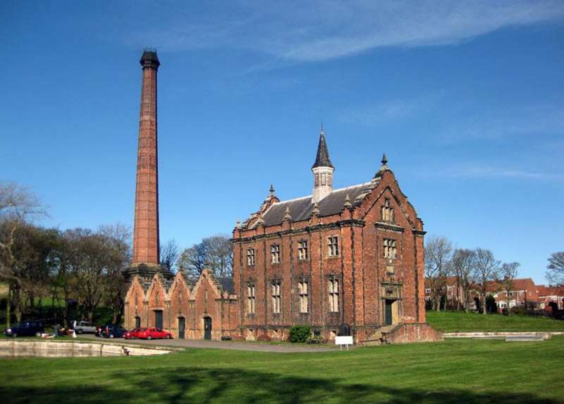
Ryhope Szivattyú állomás, 1866, Durham, GB.
