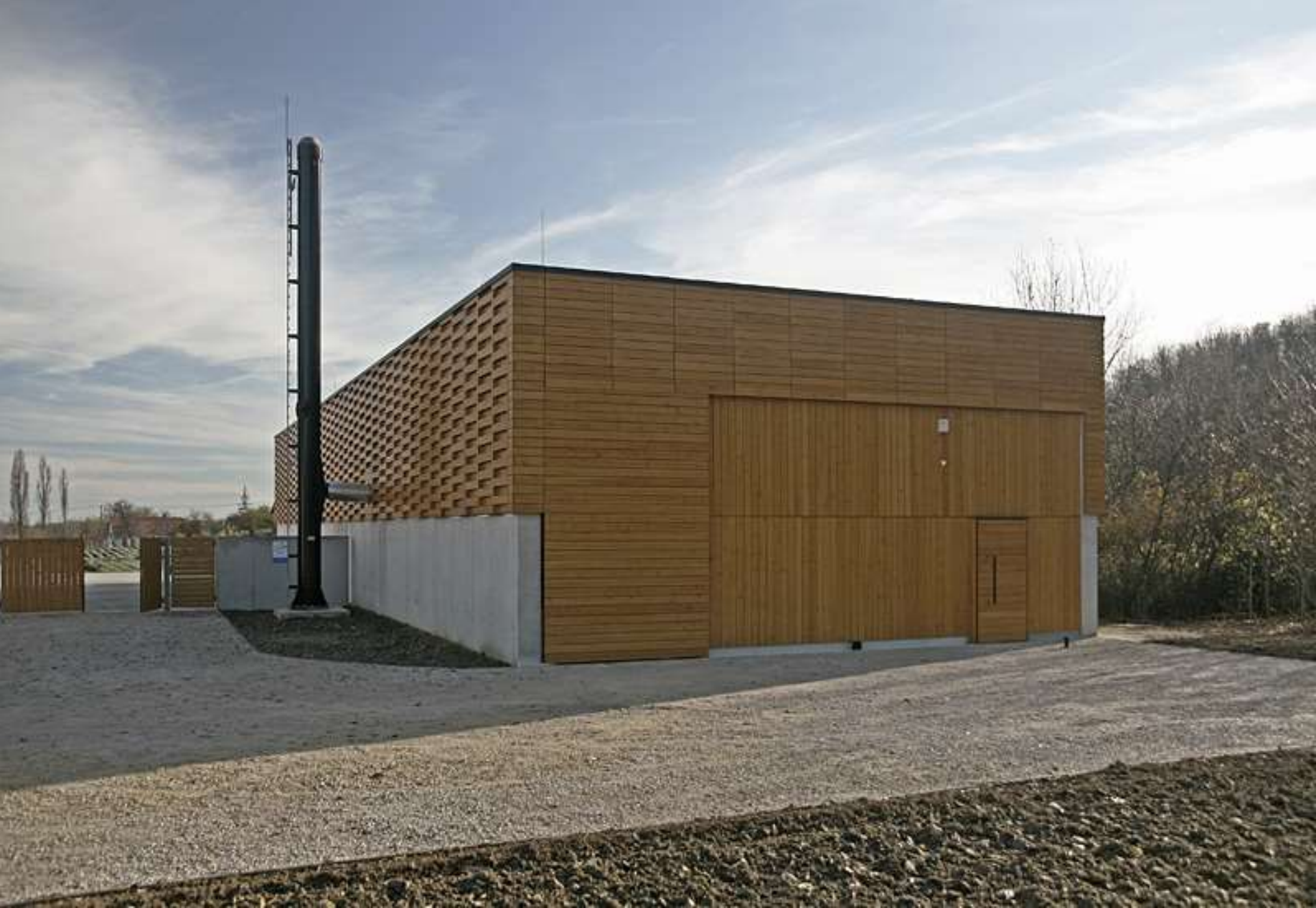
Biomassza kiserőmű, 2011, Pannonhalma, H, Czigány Tamás, Papp Róbert, Nagy András, Czita Építésziroda
