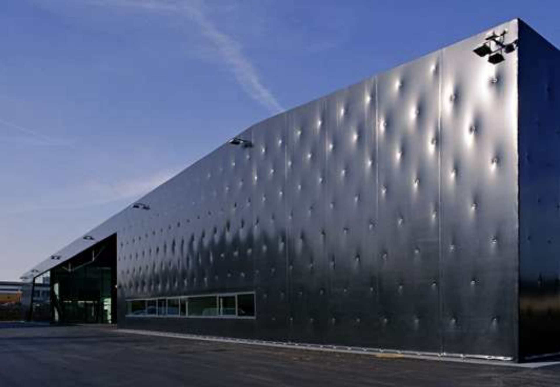
Hulladékhasznosító Üzem 2006, Linz-Ansfelden, A, Caramel Architekten
