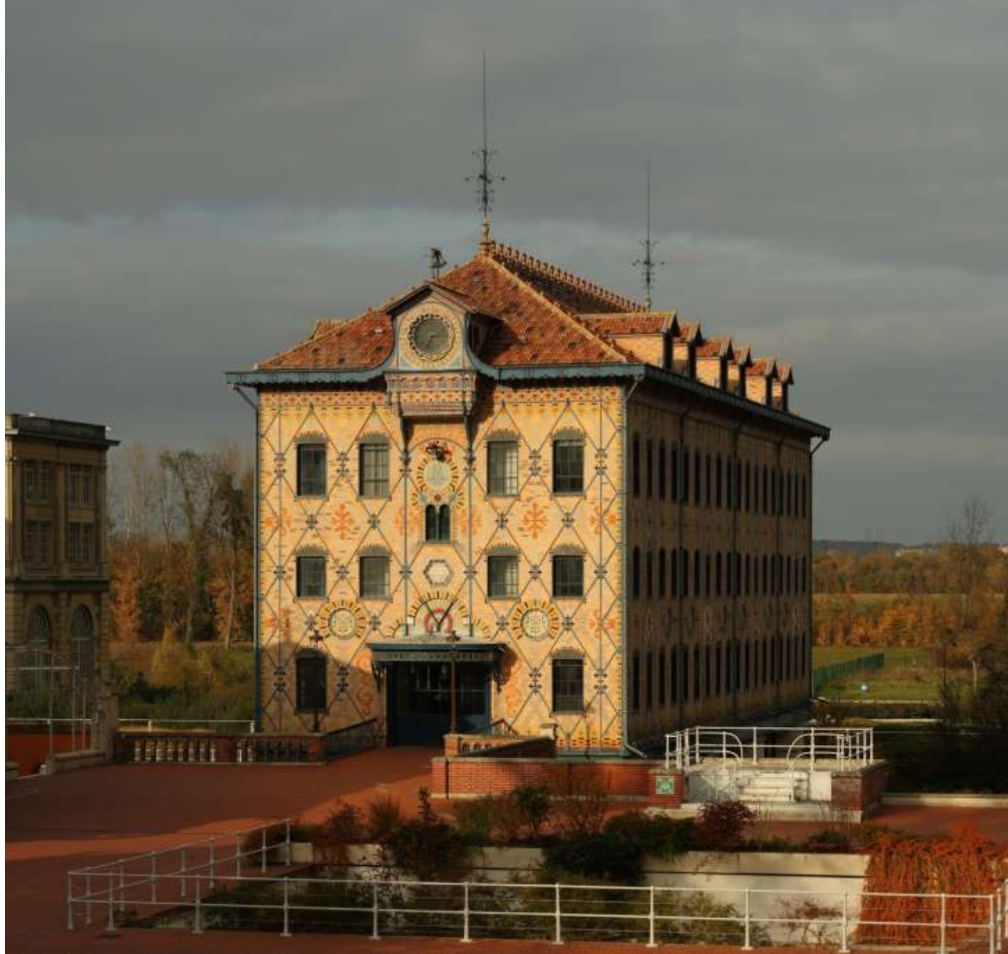
Menier Csokoládégyár szivattyúháza, Noisiel, Párizs közelében, Jules Saulnier (1817-1881) 1825-1875
