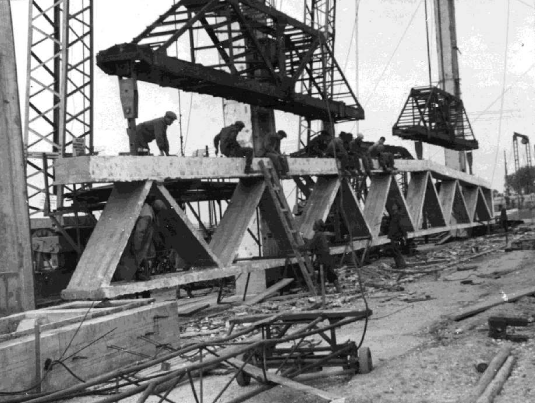
Tiszapalkonyai Hőerőmű, Főtartó emelése, 1953, IPARTERV, Mátrai Gyula, Pászti Károly
