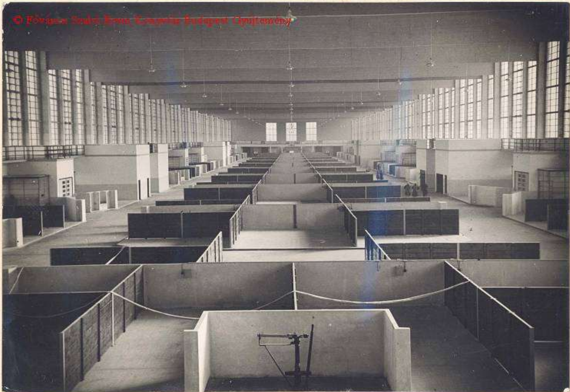
Nagyvásártelep Budapest, IX. Münich Aladár , statikus: Obrist Vilmos 1931-33, 42 m fesztáv, 17 m belmagasság, 247 m hosszú, Zeiss-Dywidag utófeszítéses technológia.
