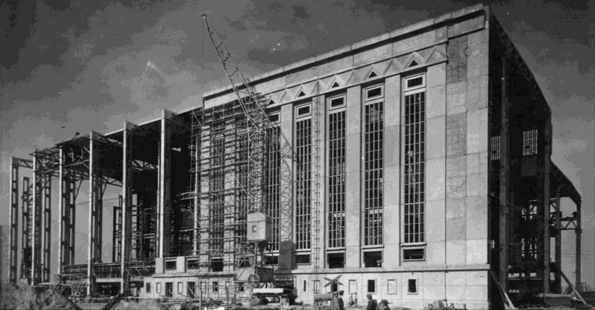
Tiszapalkonyai Hőerőmű, homlokzatépítés, 1954, IPARTERV, Mátrai Gyula, Pászti Károly
