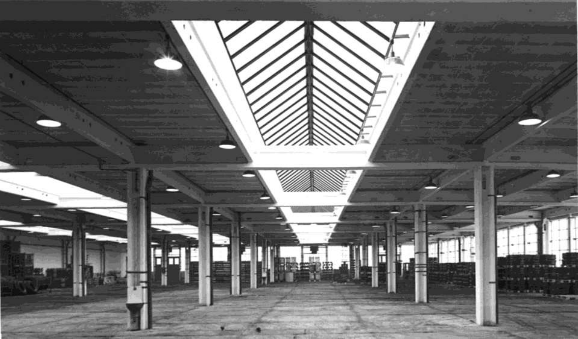
9x9 m-es típus vázszerkezet 1965, Bajnay László és Gnädig Miklós
