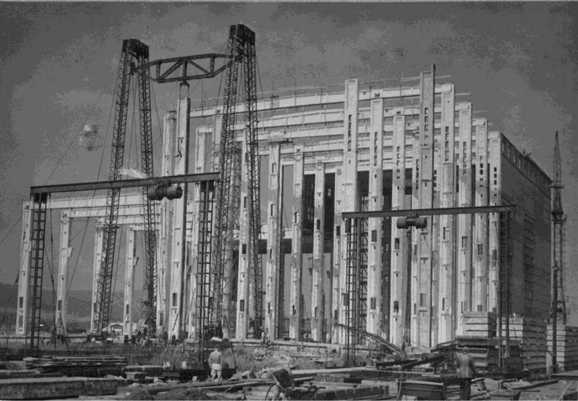
Berentei Hőerőmű, építése, 1953, IPARTERV, Mátrai Gyula, Pászti Károly
