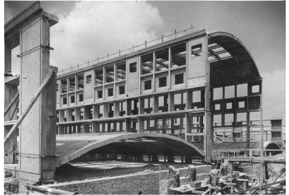
Az oldalhajó elkészült tetőelemei a talajon, háttérben a szerkezeti elkészült főhajó
