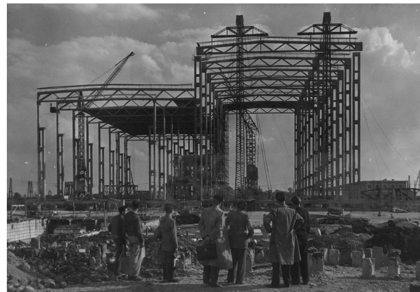
A Tiszai Hőerőmű építése Tiszapalkonyán (IPARTERV, 1952-1957, Mátrai Gyula, Pásztí Kálmán) művezetés, vasbeton Vierendeel pillérek, rácsos vasbeton főtartók
