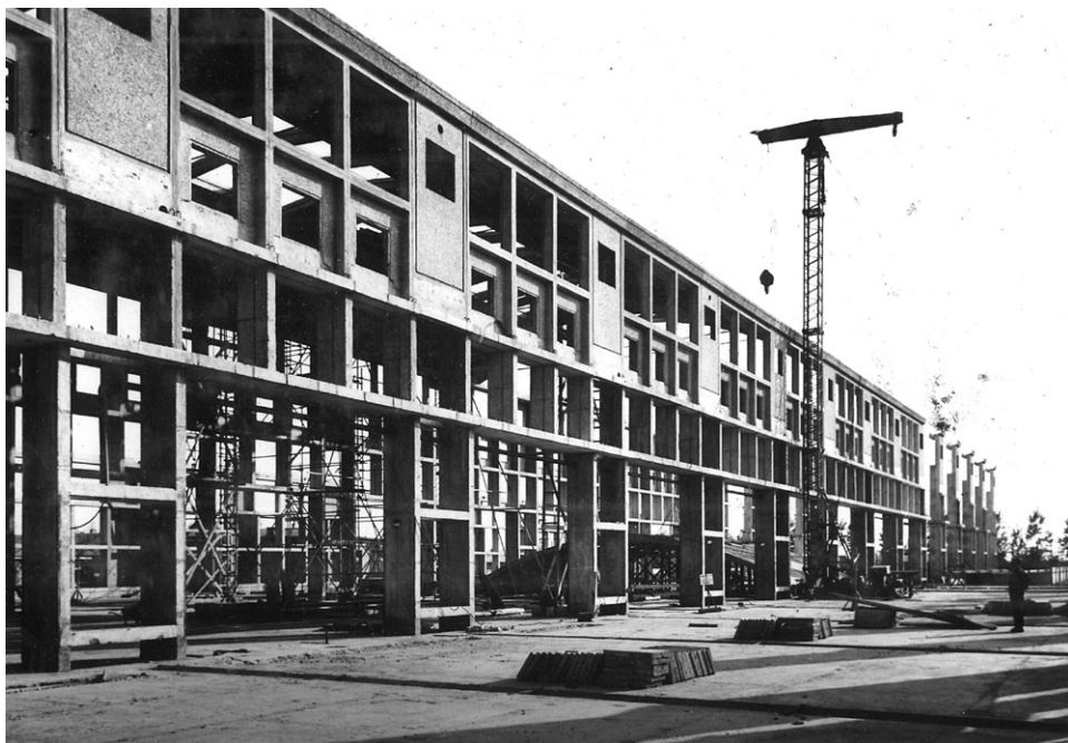
A középső hajó építése
