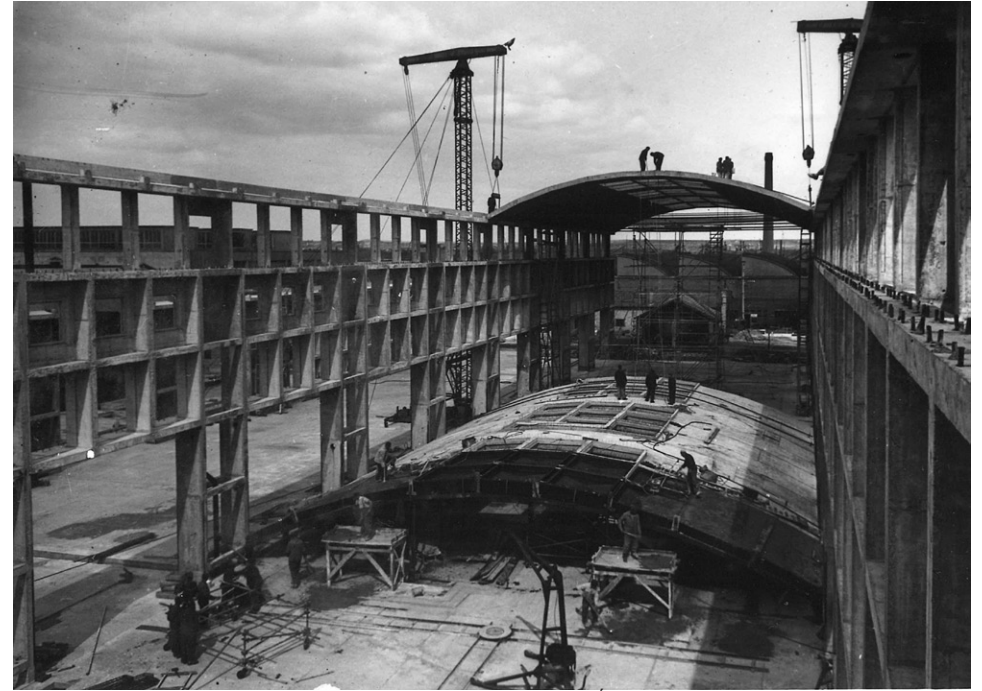
Ives tetőelemek készítése a falpillérek között
