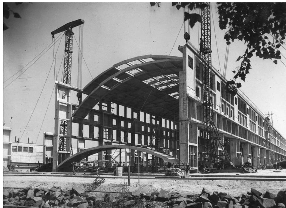
A főhajó vonórudas héjelemének beemelése
