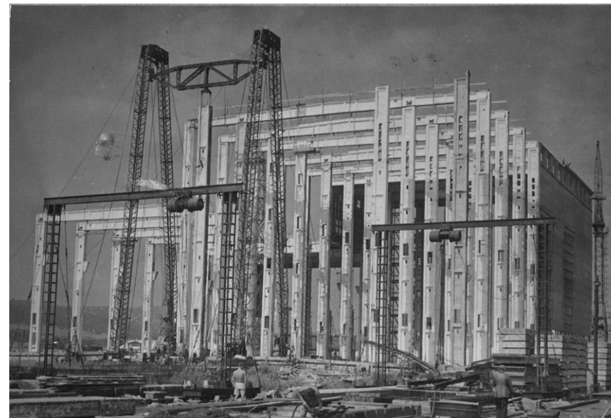
Borsodi Hőerőmű, Berente, (IPARTERV 1952-1954, Mátrai Gyula, Pásztí Károly) Pillérek és főtartók szerelése-emelése dupla bakdarukkal
