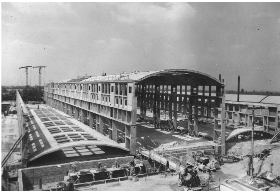
a háromhajós csarnok építése, az oldalhajók tetőelemei a talajon, beemelés előtt, a teherhordó homlokzati falak már állnak
