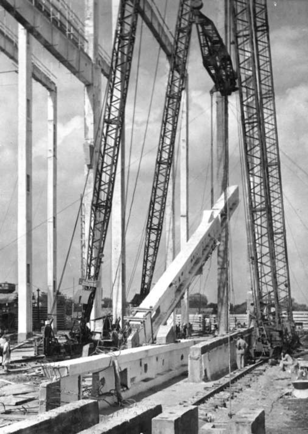
Berentei 200 MW Hőerőmű építkezése 1951-57 IPARTERV Mátrai Gyula és Pásztai Károly
