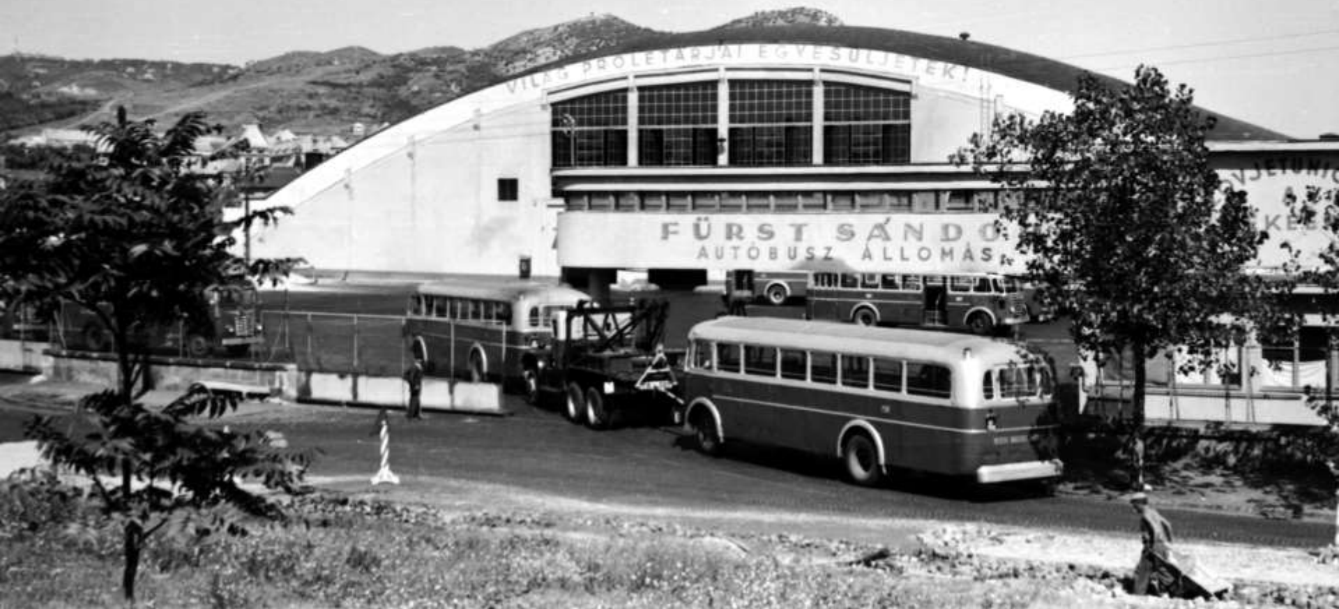
Kelenföldi Buszgarázs Budapest, XI. 1938-41, Menyhárd István (vonórudas vasbeton héj 82 m!) építész: Padányi-Gulyás Jenő
