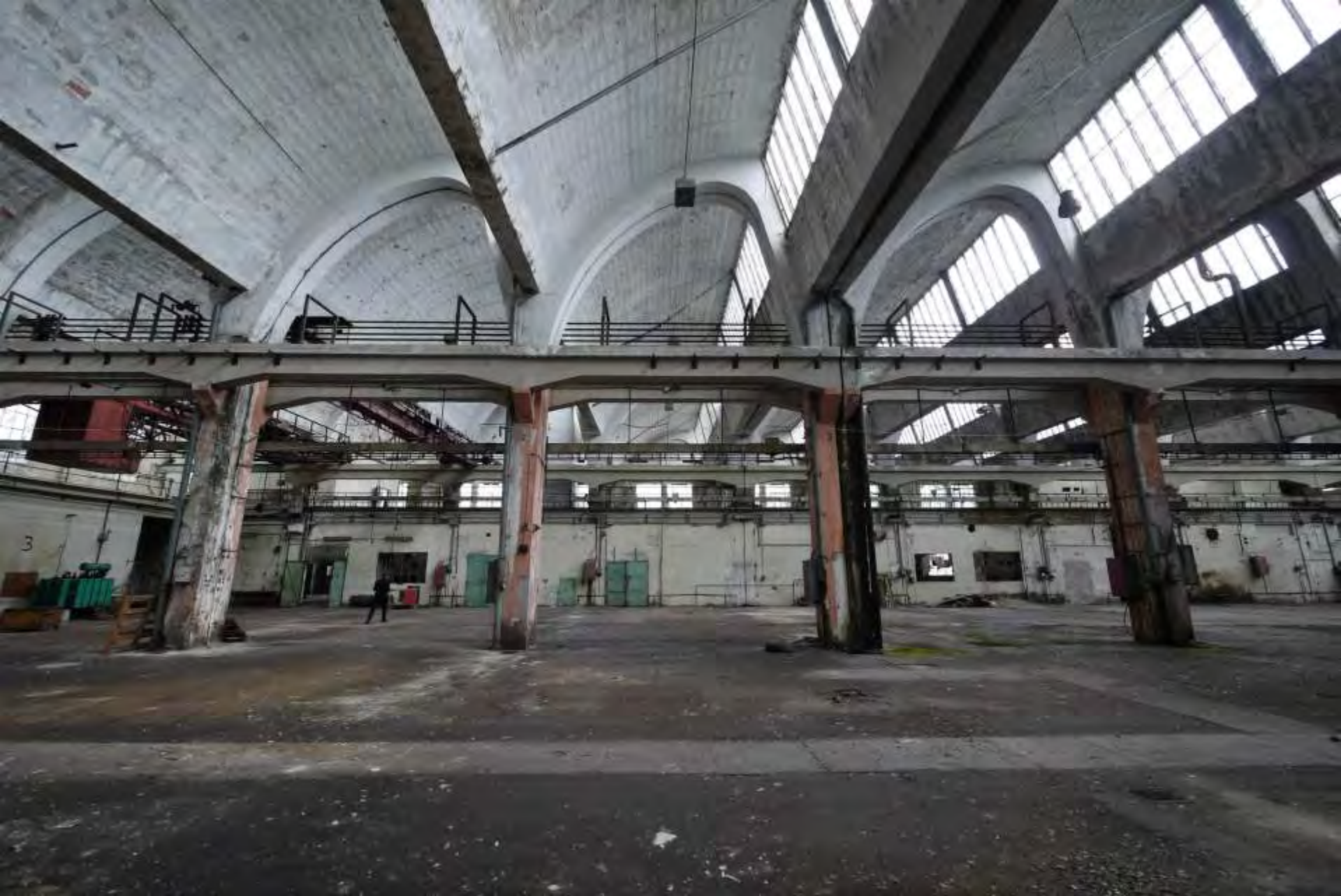
WM Dunai Repülőgépgyár, Csepel Autógyár szerelőcsarnoka, Szigetszentmiklós, 1941-1945 Építész Sailer István, statikus: Gnädig Miklós?
