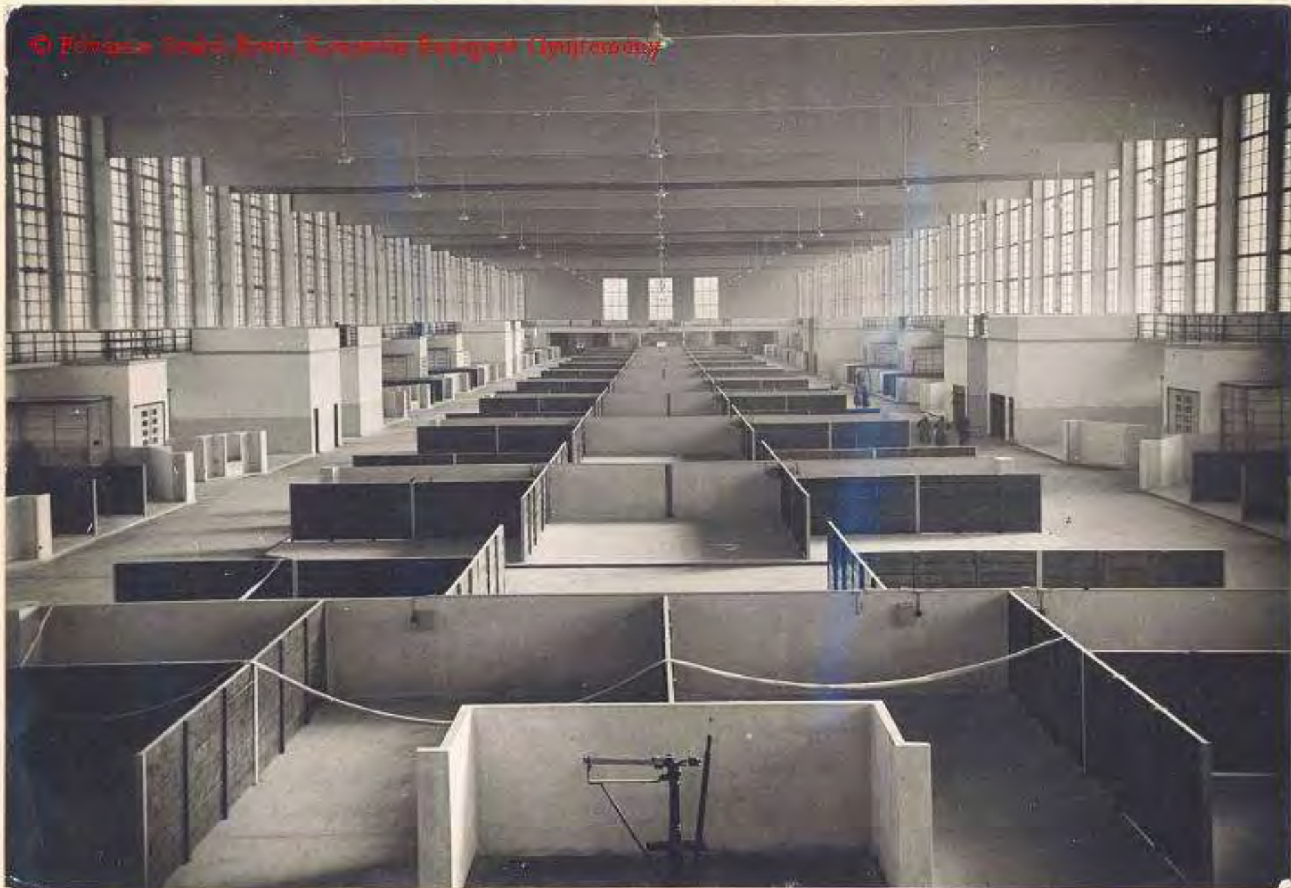
Nagyvásártelep Budapest, IX. Münich Aladár , statikus: Obrist Vilmos 1931-33, 42 m fesztáv, 17 m belmagasság, 247 m hosszú, Zeiss-Dywidag utófesztíteses technológia.
