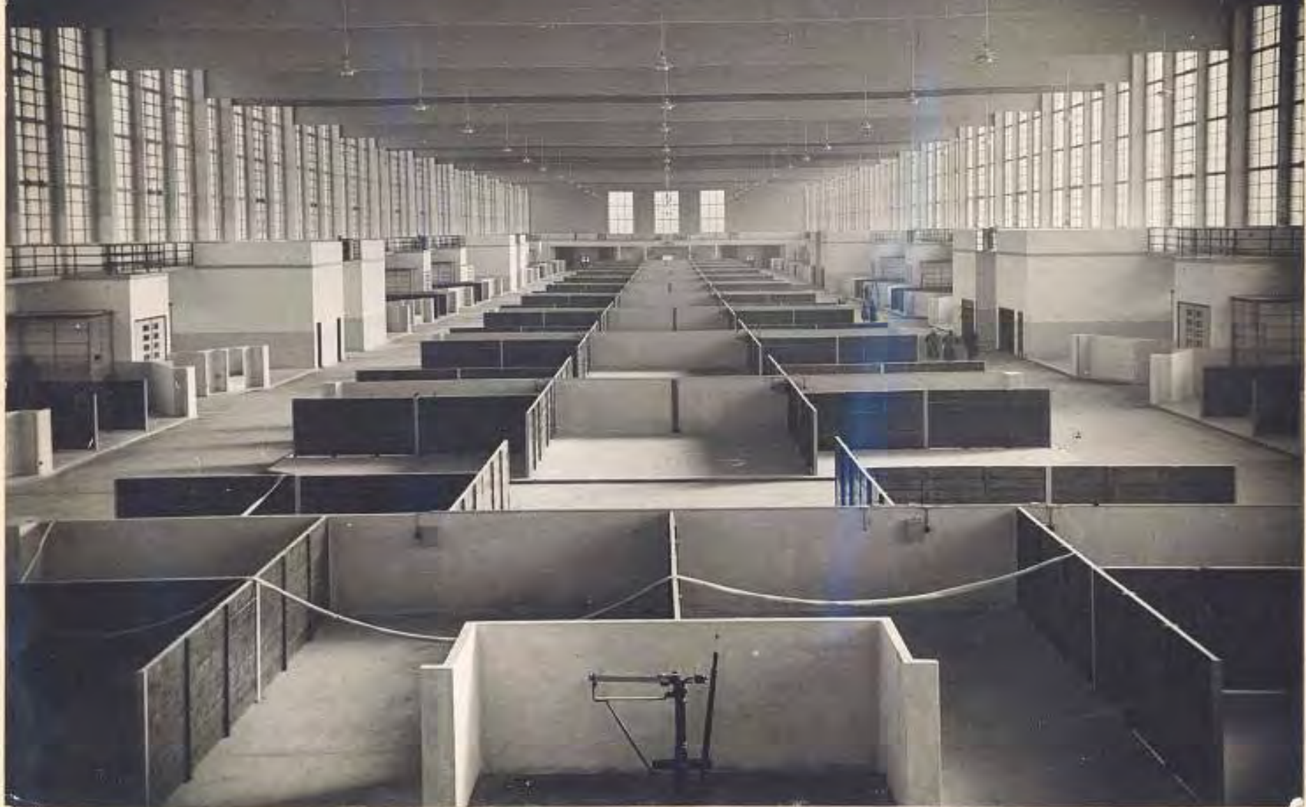
Nagyvásártelep Budapest, IX. Münich Aladár , statikus: Obrist Vilmos 1931-33, 42 m fesztáv , 17 m belmagasság, 247 m hosszú
