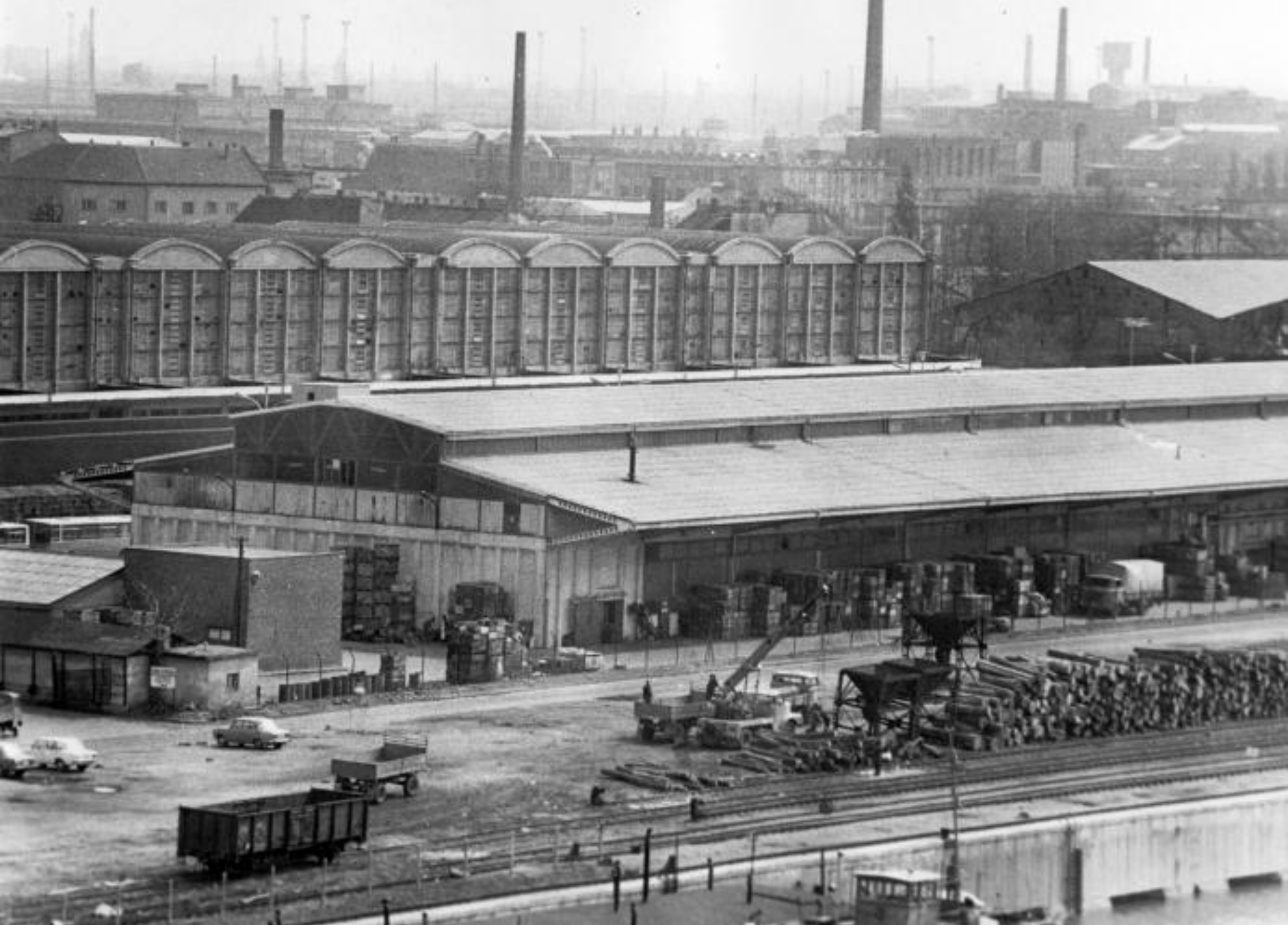
Nagyvásártelep Budapest, IX. Münich Aladár , statikus: Obrist Vilmos 1931-33, 42 m fesztáv , 17 m belmagasság, 247 m hosszú
