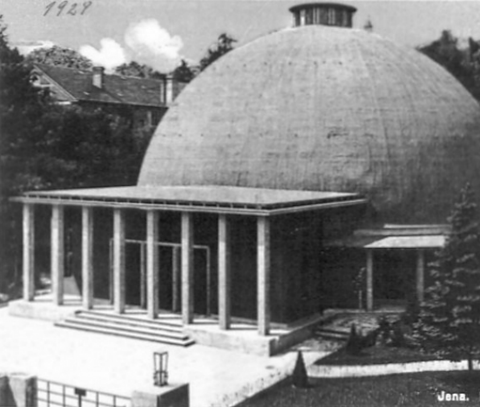
Planetárium, Jena, D, statikus: Franz Dischinger 1922, 25 m fesztáv , v=6 cm
