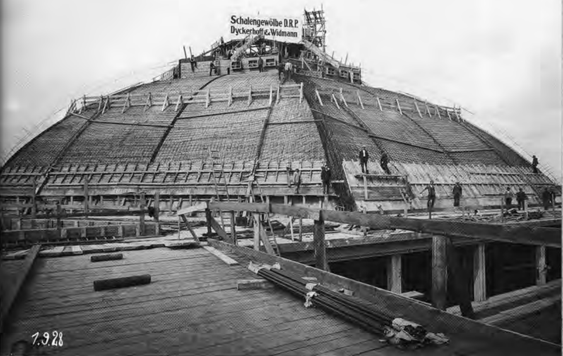
Markthalle, Lipce, D, statikus: Franz Dischinger 1930, 75 m fesztáv , 29 m magas
