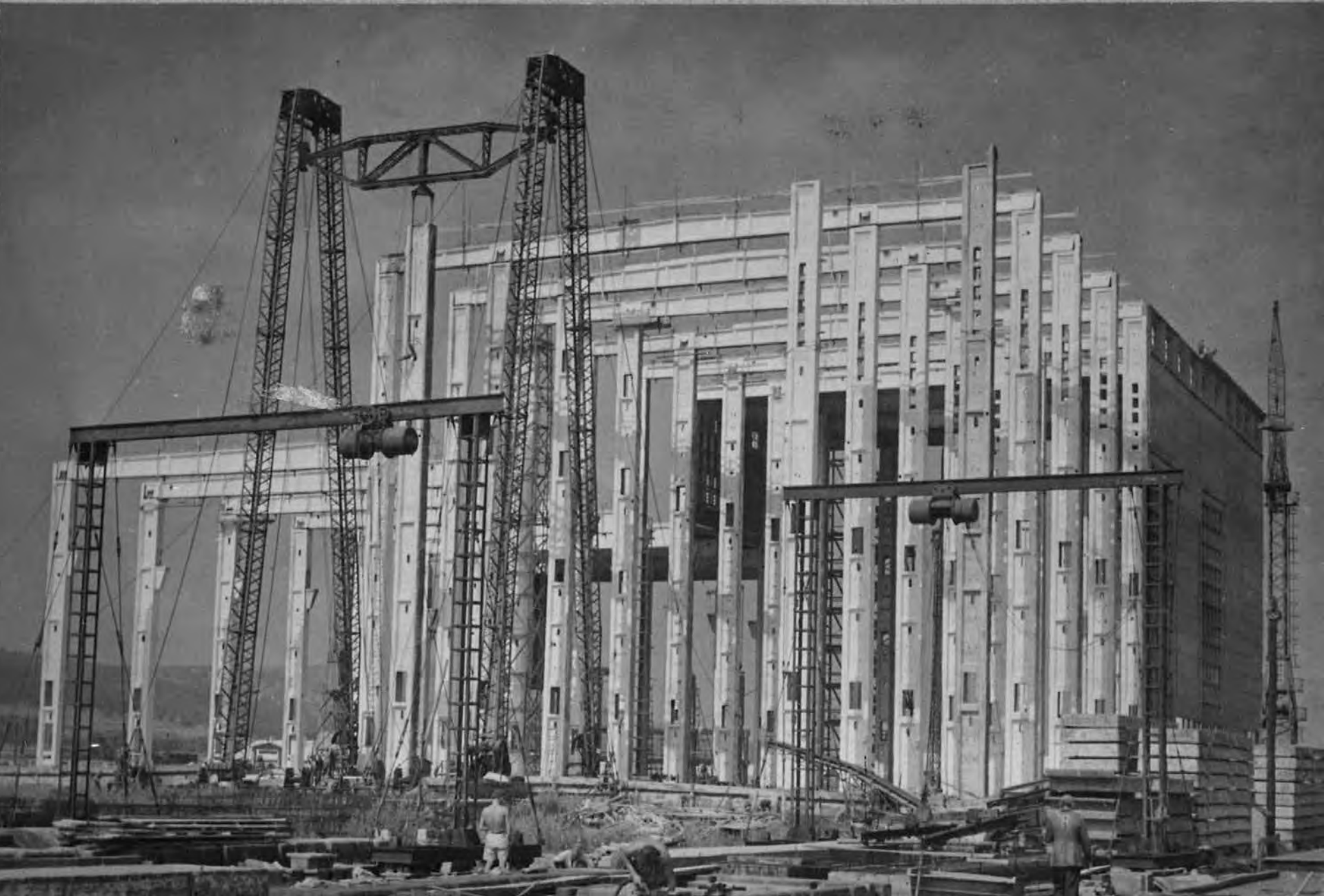
Borsodi Erőmű építése, Berente, 1953, Mátrai Gyula, Pászti Károly
