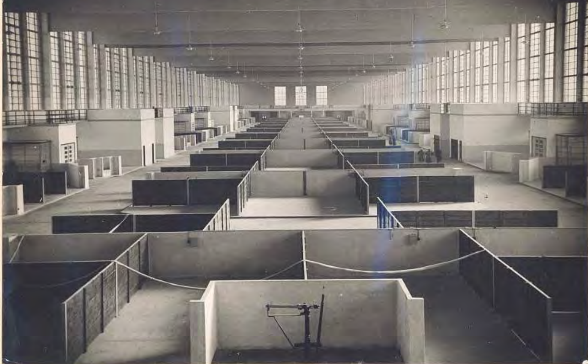
Nagyvásártelep Budapest, IX. Münich Aladár , statikus: Obrist Vilmos 1931-33, 42 m fesztáv, 17 m belmagasság, 247 m hosszú, Zeiss-Dywidag utófesztítes technológia.
