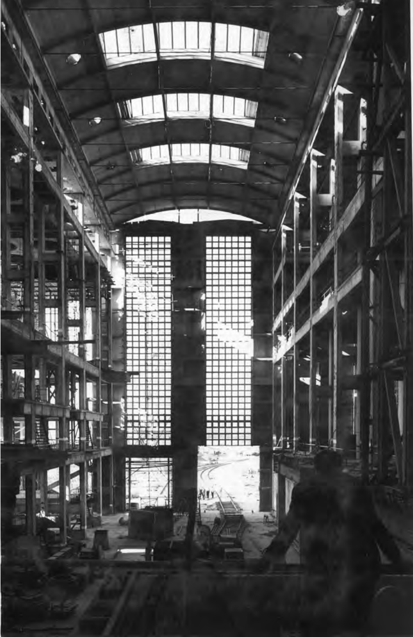
Pécsújhelyi Hőerőmű kazántér, falpillér emelése 1958, IPARTERV, Mátrai Gyula, Pászti Károly
