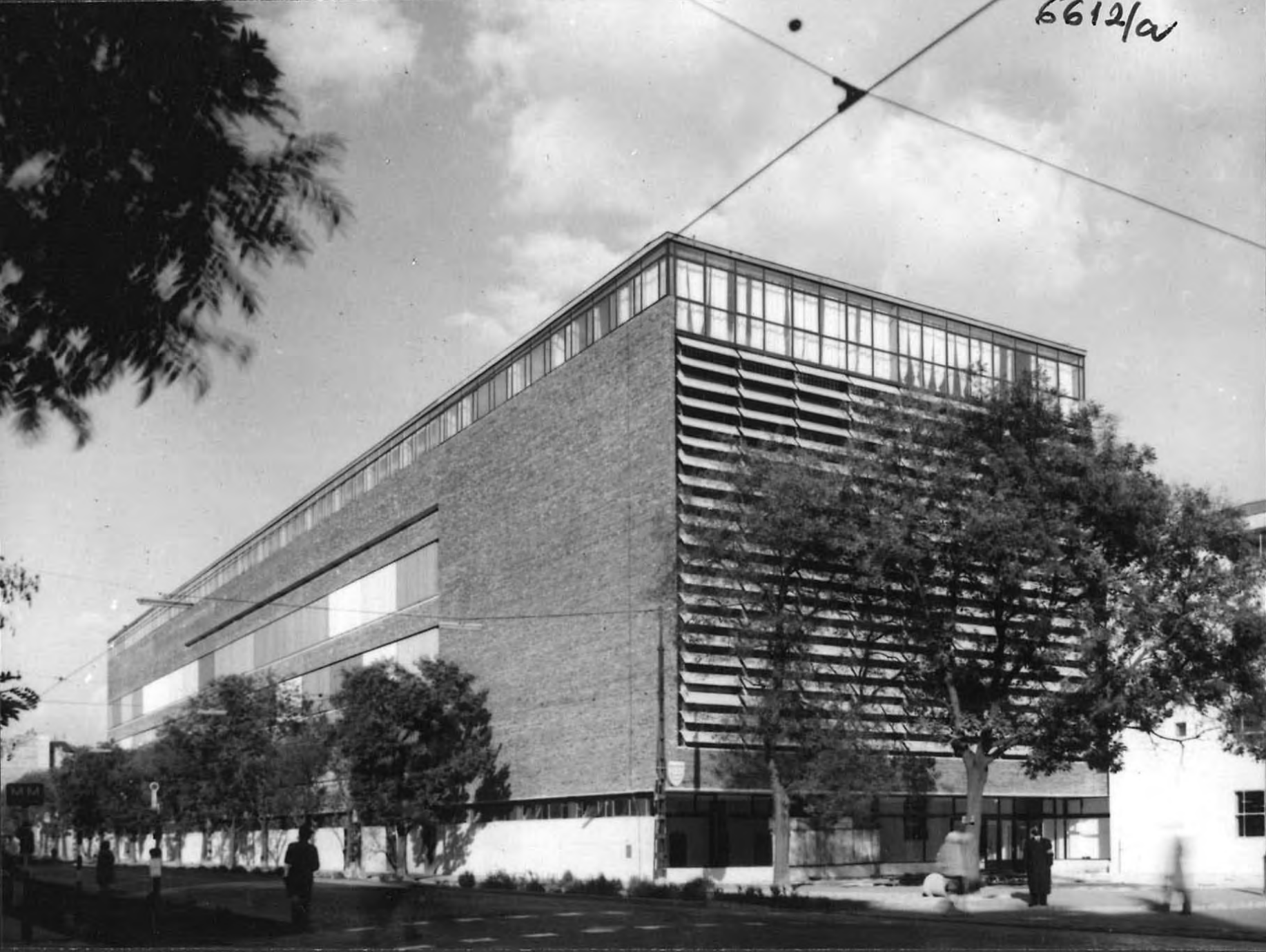
Beloianisz Híradástechnikai Gyár, BHG, Budapest, XI. Fehérvári út, 1964, Arnóth Lajos és Szendrői Jenő
