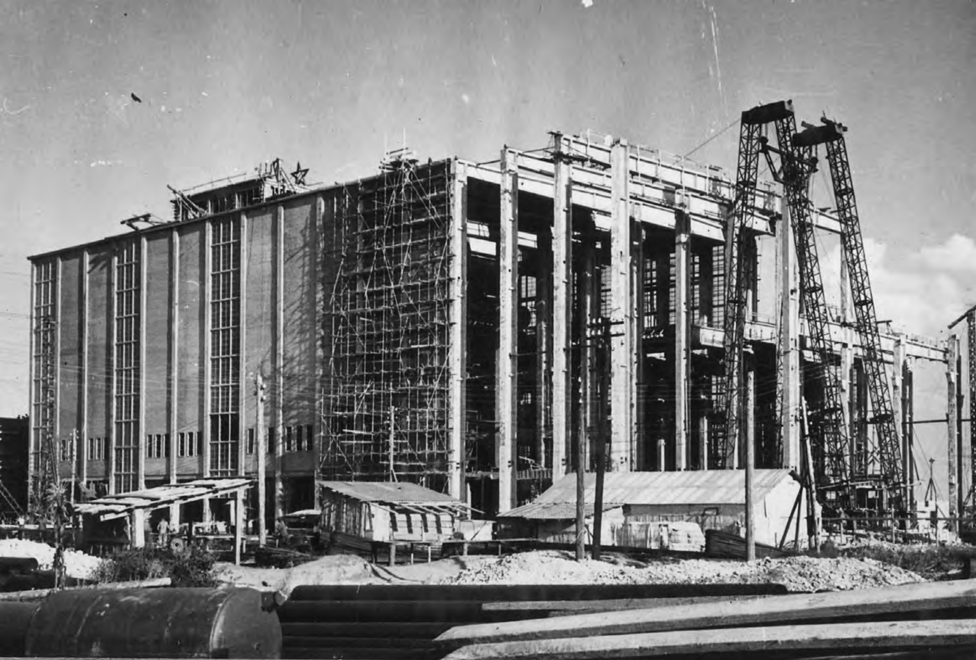
Inotai Hőerőmű, építés közben, 1950, IPARTERV, Mátrai Gyula, Pászti Károly
