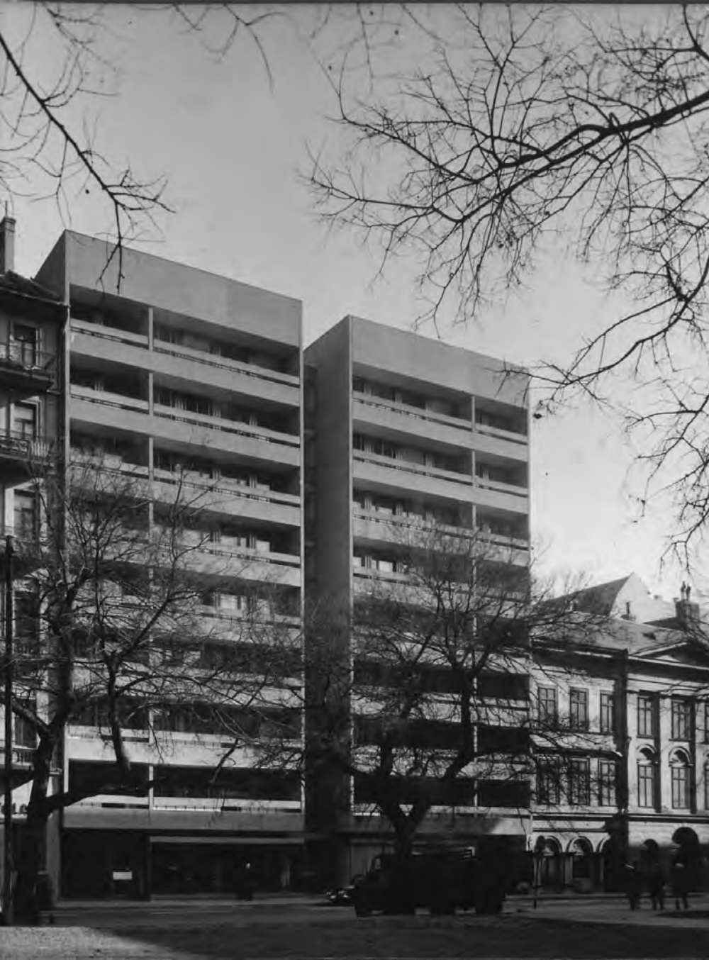
Lakóház, Bp.V. József nádor tér 8. 1966. Földesi Lajos
