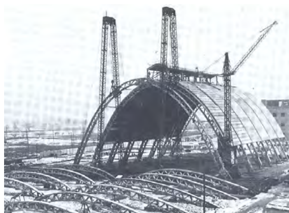
Kazincbarcikai Műtrágyaraktár, rácsos ívek emelése, födémelemek elhelyezése
