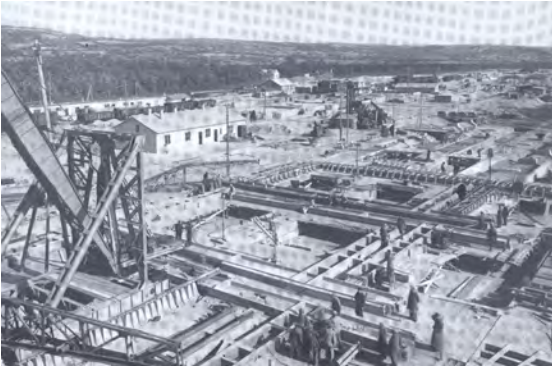
Inotai Erőmű, kertelem előregyártása
