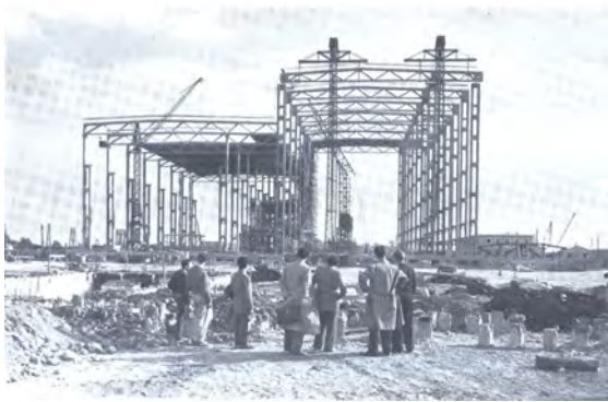
Tiszapalkonyai Erőmű, keretfőtartó beemelése
