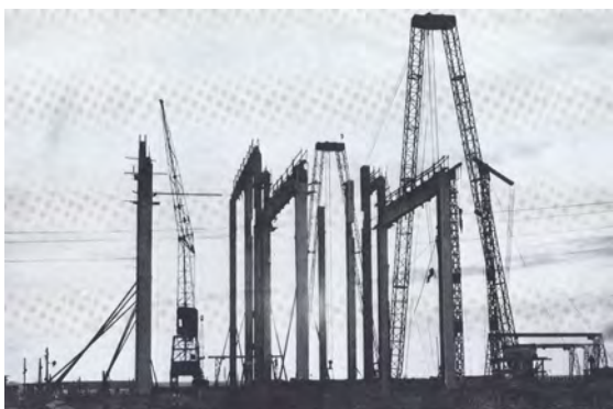
Dunajvárosi Erőmű, keretszerkezet emelése
