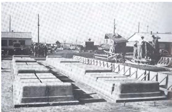
Dunajvárosi Erőmű, födémelemek gyártószablonja
