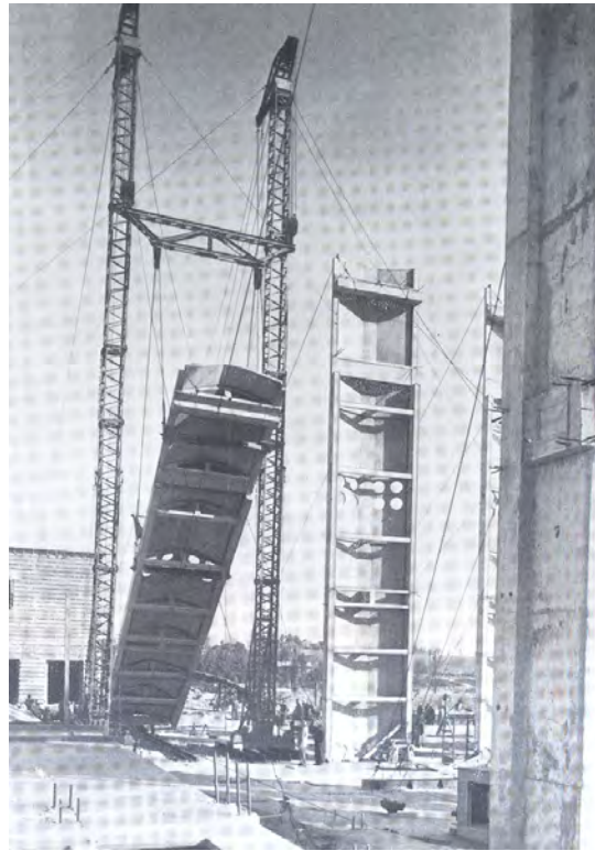
Pécsújhelyi Erőmű, pillérelém mozgatása, emelése
