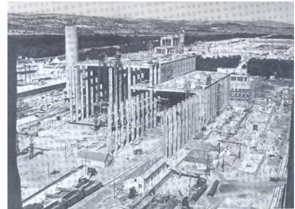
Inotai Erőmű, távlati kép építés közben 1.
