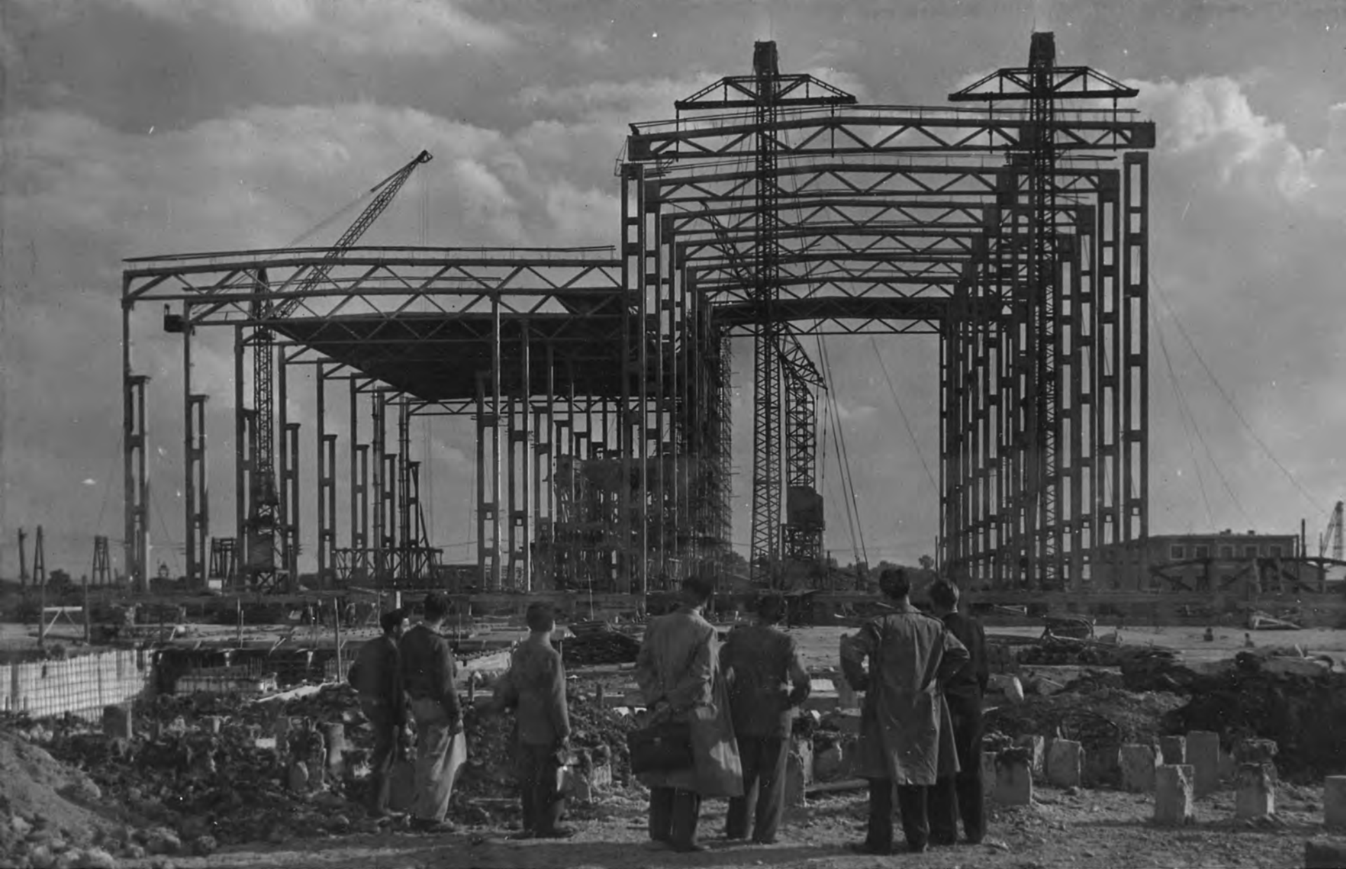
Tiszapalkonyai Hőerőmű, Főtartó emelése, 1953, IPARTERV, Mátrai Gyula, Pásztai Károly
