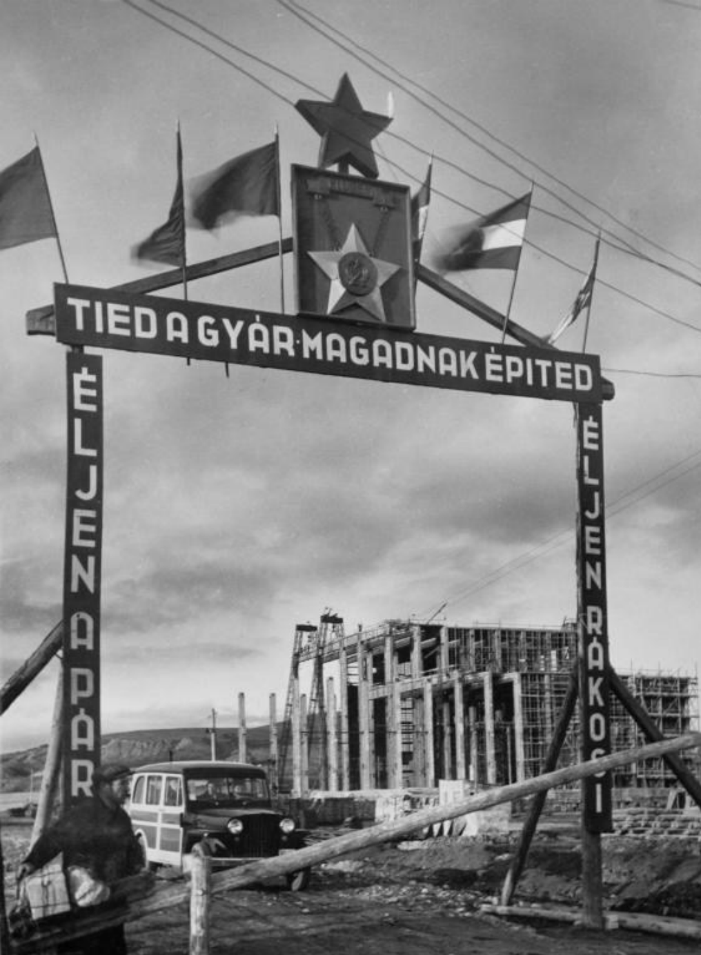
Az Inotai Hőerőmű építése 1950
