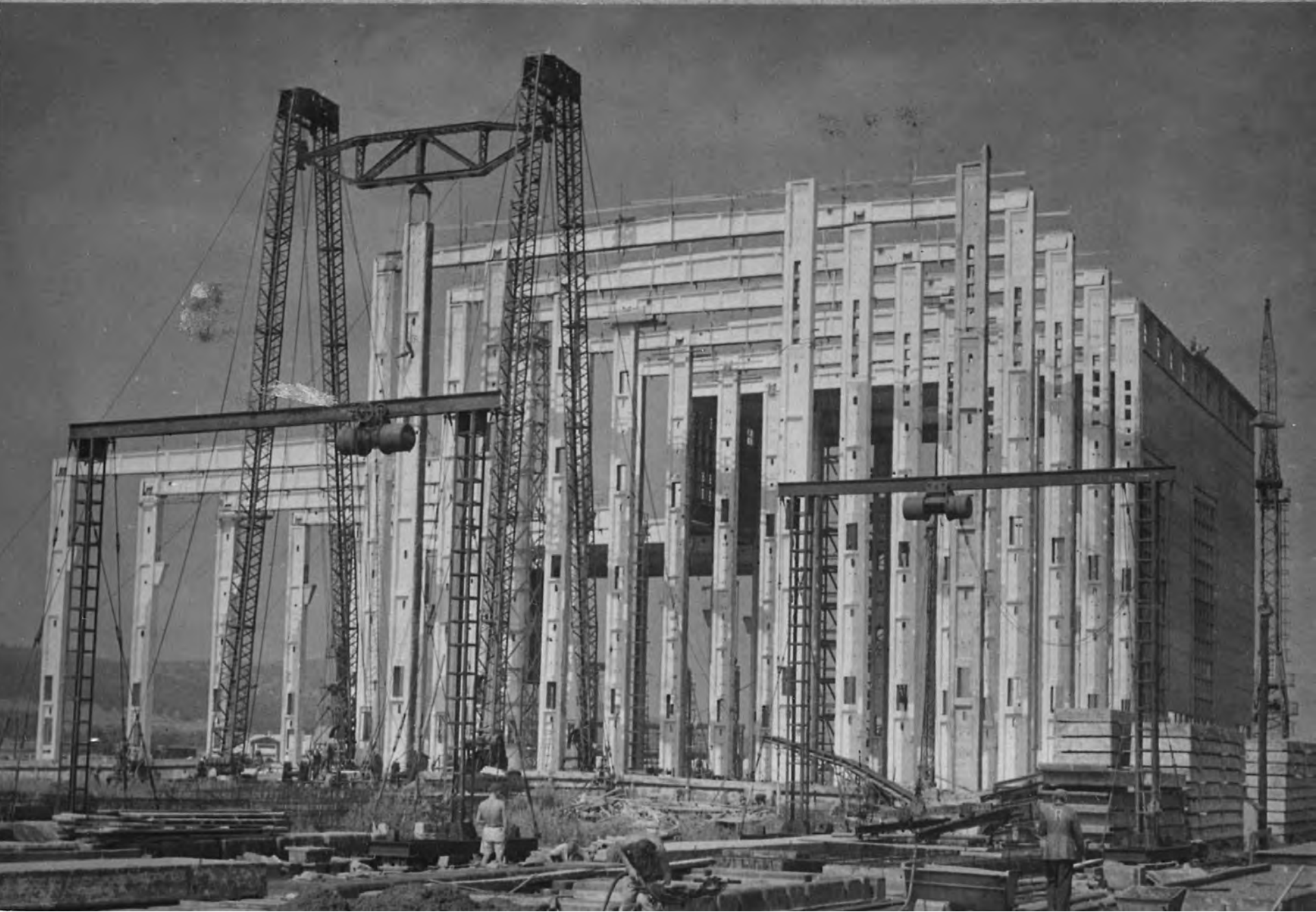
Berentei Hőerőmű, építése, 1953, IPARTERV, Mátrai Gyula, Pásztai Károly
