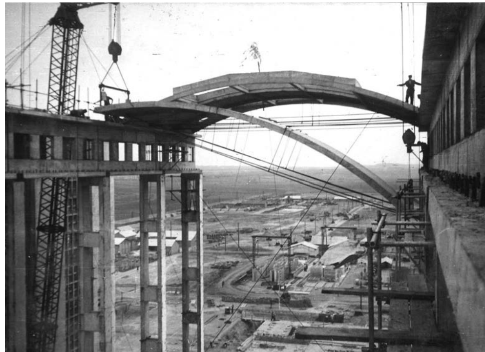
A lépték. A kazánház lefedését biztosító dongaelem elhelyezése. A terepszinten az "előregyártó üzem"
