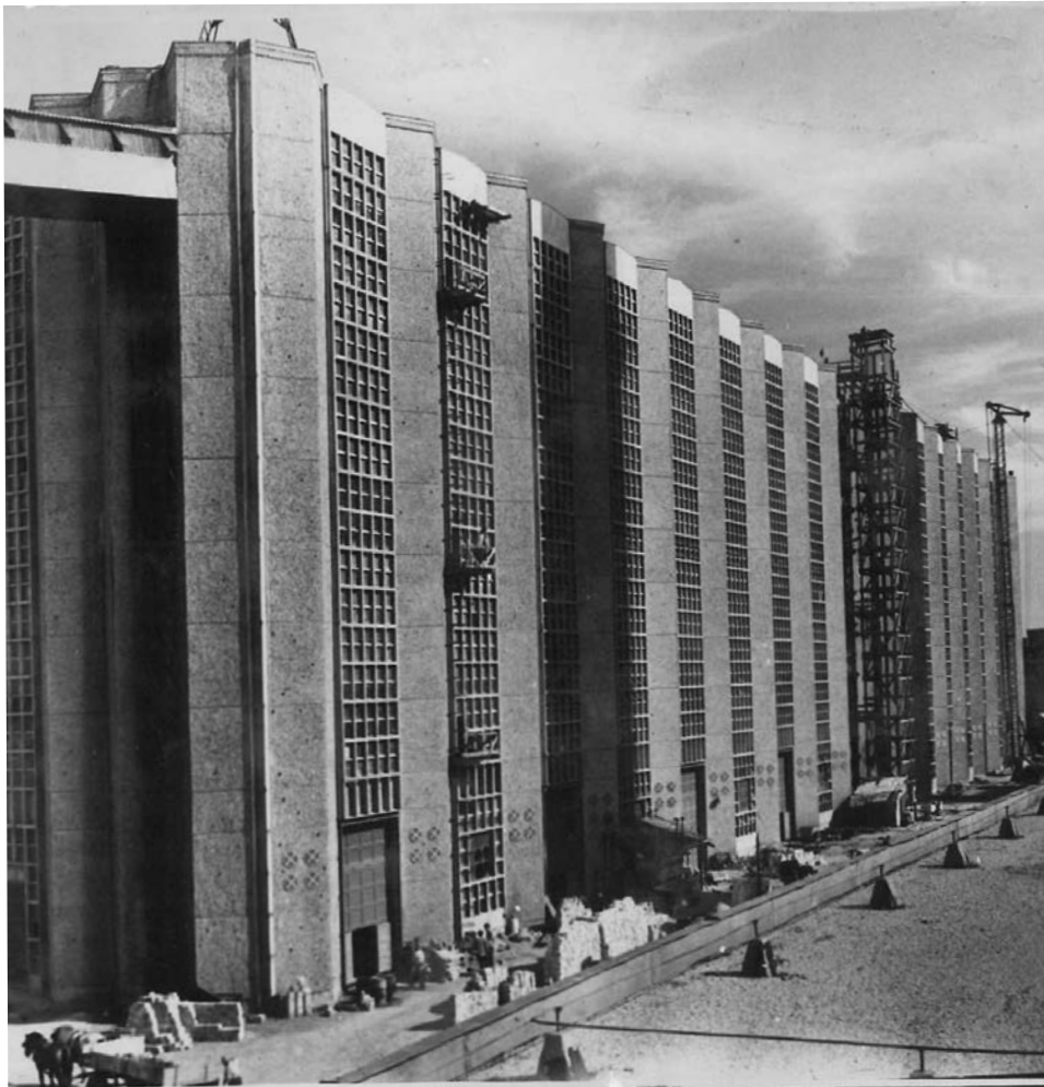
A kazánház homlokzata
