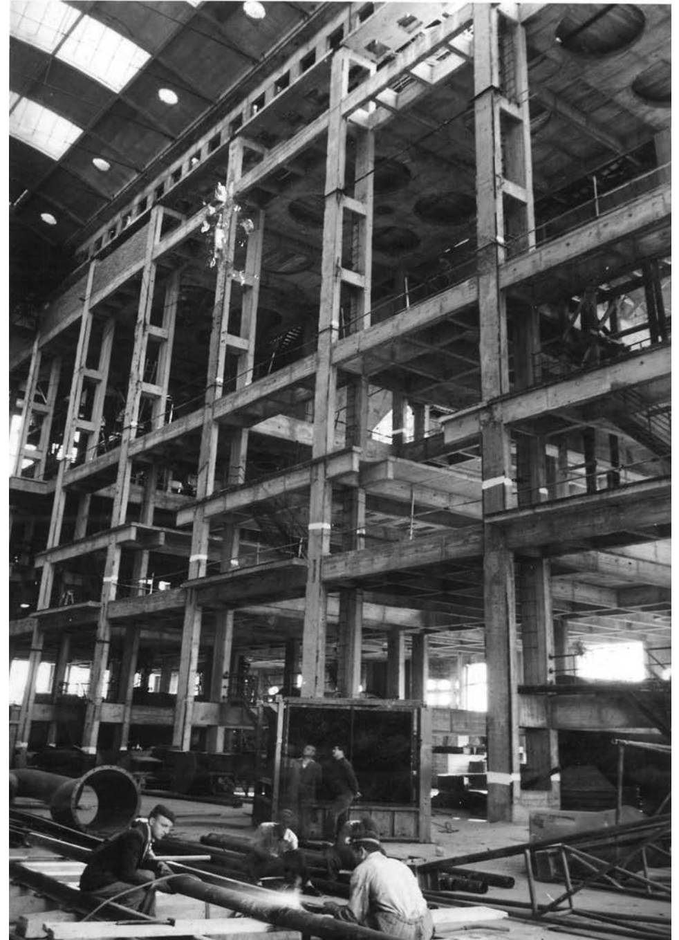
A kazánház belső tere.
