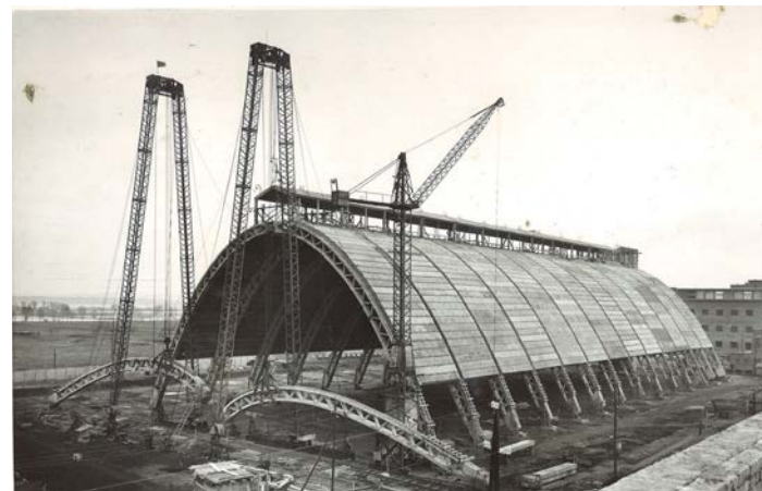
A hátrpmcsuklós ív beemelése két-két jellegzetes bakdaruval
