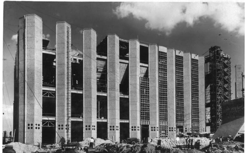
A kazánház homlokzata. A teherhordó V alaprajzú faltestpillérek közé később helyezik el a bevilágítást biztosító vasbeton keretes üvegfalmezőket.
