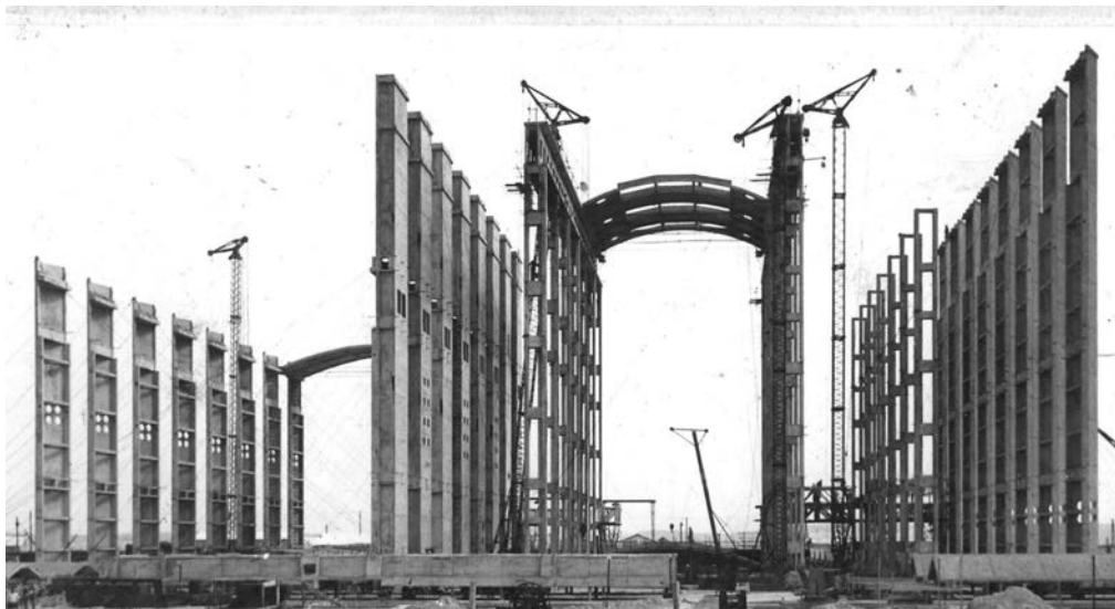
A kazánház és a gépcsarnok falpillérei állnak, elkezdődött a lefedést adó aláfeszített dongaelemek beemelése, nézet a kazánház tengelyében
