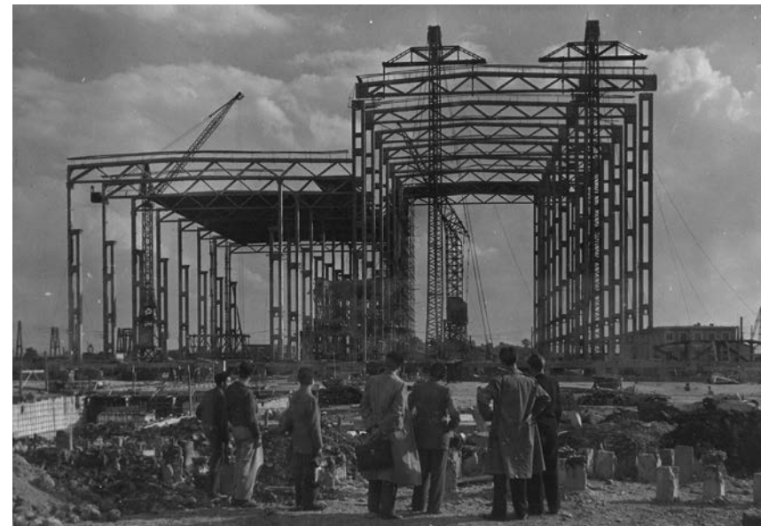
A Tiszai Hőerőmű építése Tiszapalkonyán (IPARTERV, 1952-1957, Mátrai Gyula, Pászti Károly) művezetés, vasbeton Vierendeel pillérek, rácsos vasbeton főtartók
