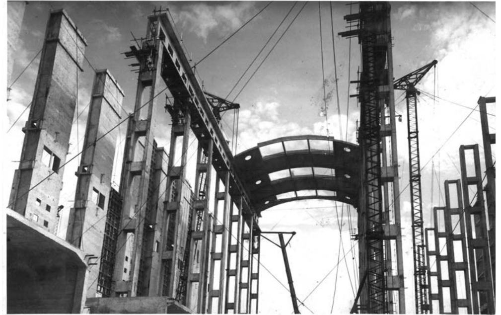
A kazánház és a gépcsarnok falpillérei állnak, elkezdődött a lefedést adó aláfeszített dongaelemek beemelése, nézet kazánházból. Jól látható, hogy a közbenső pillérek Vierendeel rendszerűek.
