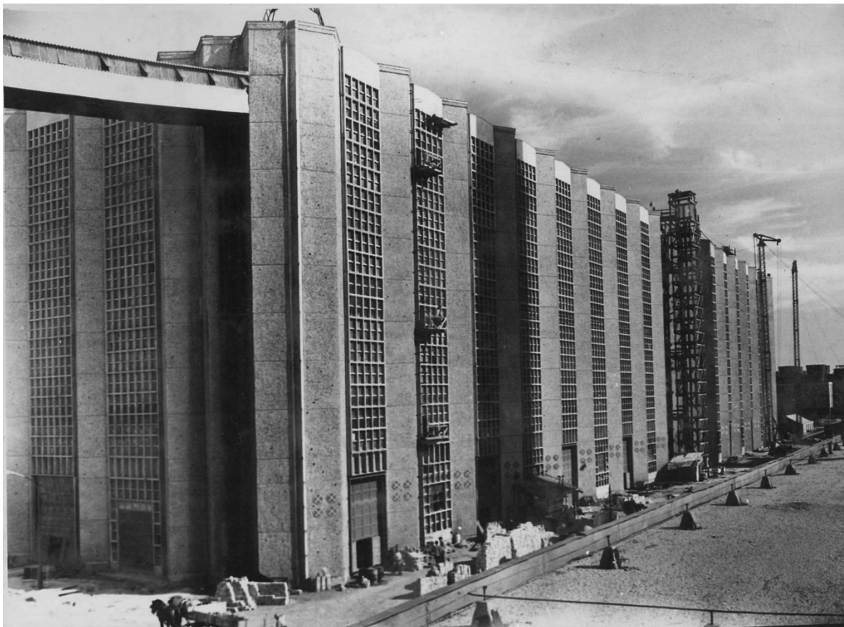
11.kép A kazáncsarnok homlokzati részlete No. 4551
