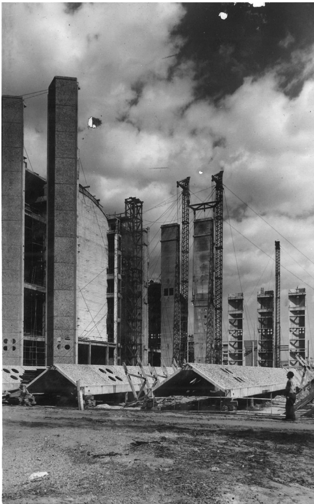
7.kép A panelváz elemek még a földön. Megfigyelhető az elem léptéke a mellette álló munkáshoz hasonlítva. A panelek „kavicsolt” homlokzati felületűek. No. 3383
