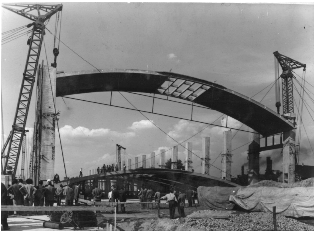
14.kép: Kábelgyár, az első donga emelése No. 5463
