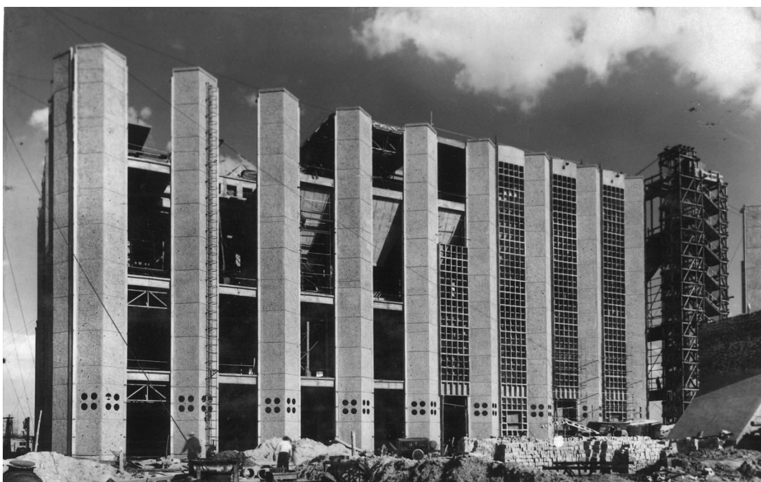
6.kép Nézet a kazáncsarnok felől. A falpanelek között szintén előregyártott vasbeton keretes üvegfelület épül. A homlokzat mögött felsejlik a szénbunkerek monolit technikával épülő sora. No. 3380
