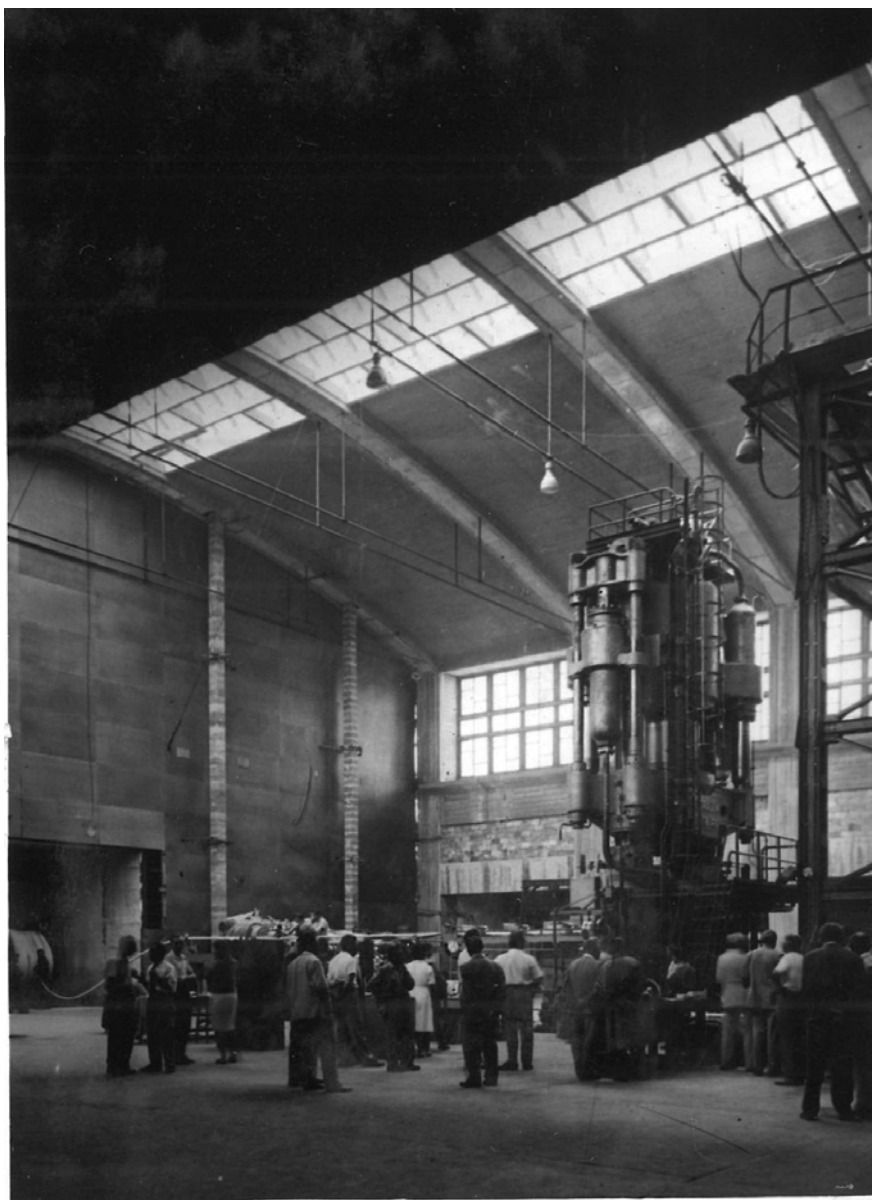
16.kép: Kábelgyár, a főhajó belső képe a technológiai szerelés közben No.5825
