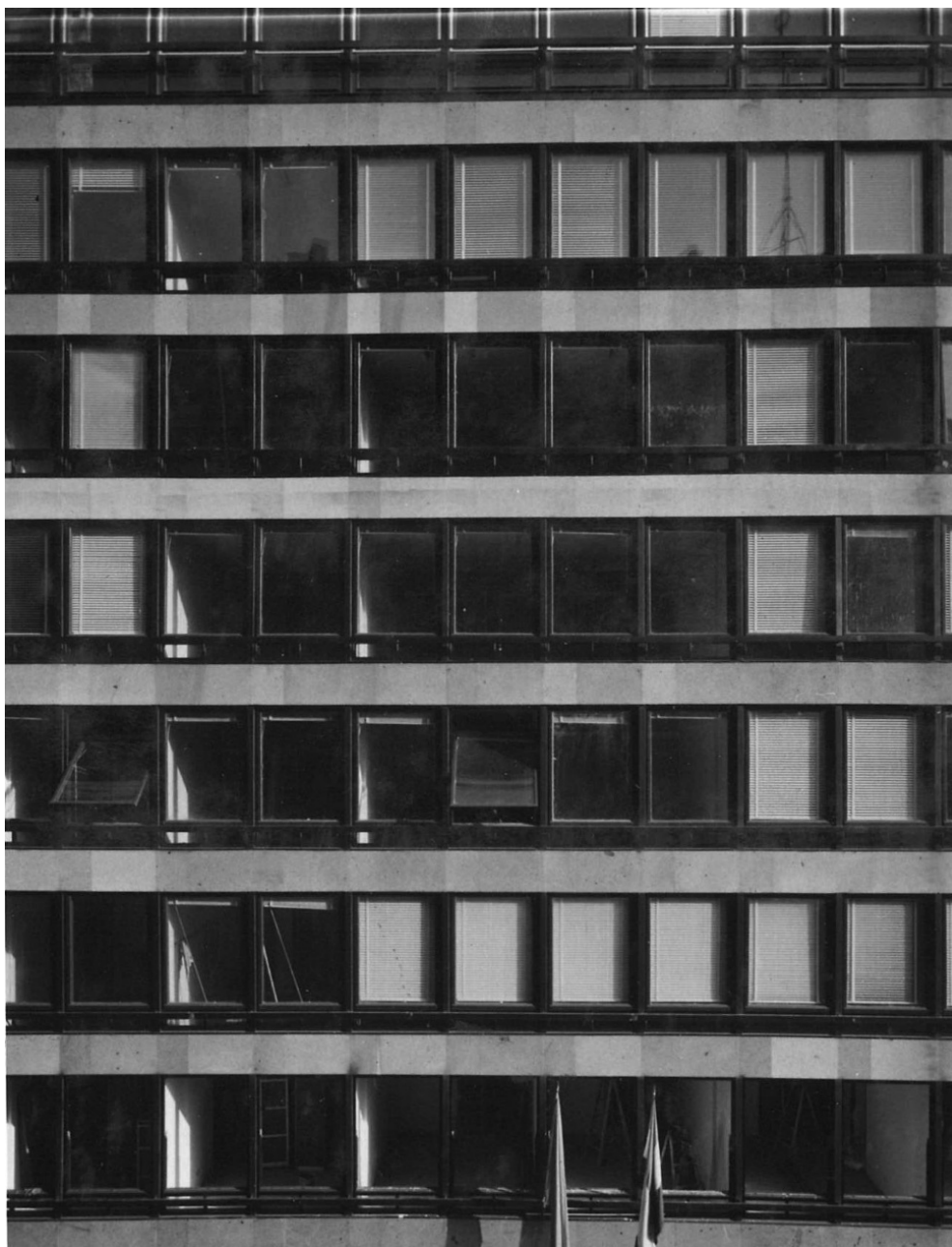
11.kép. A megépült homlokzat részlete. A mellvédsáv a már említett szürke gránit. No. 5891
