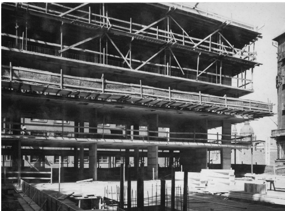
8.kép. Szerkezetépítés, udvari oldal, a pénztárterem tetején állva. No. 5849
