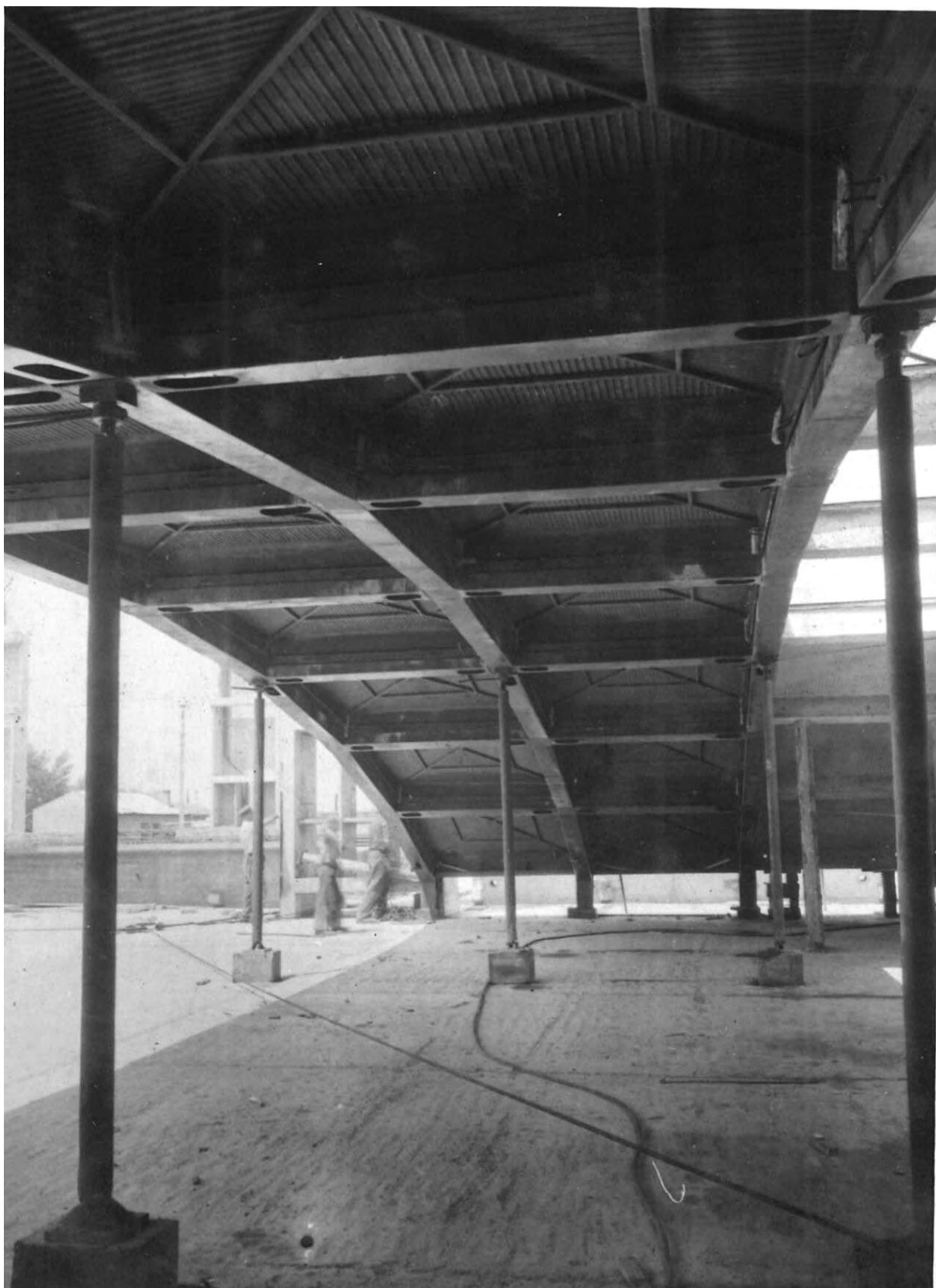
7.kép: IKARUS, a donga zsaluzatának váza alulnézetben, a rájuk helyezett zsalumezőkkel No. 3885
