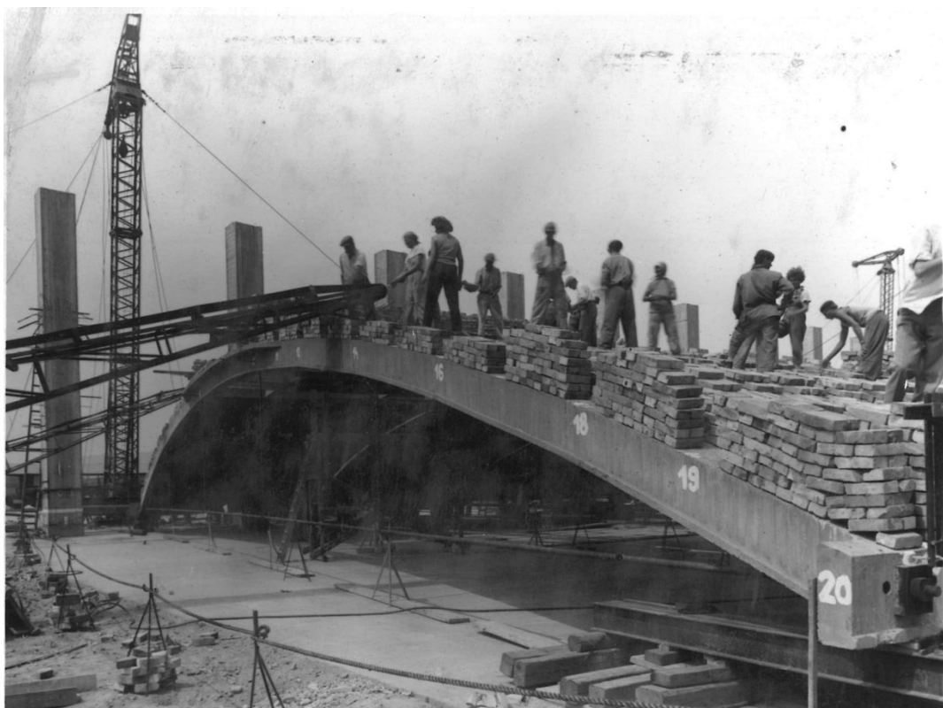
13.kép: Kábelgyár, az elkészült domba próbaterhelése (előkészület) No. 5448
