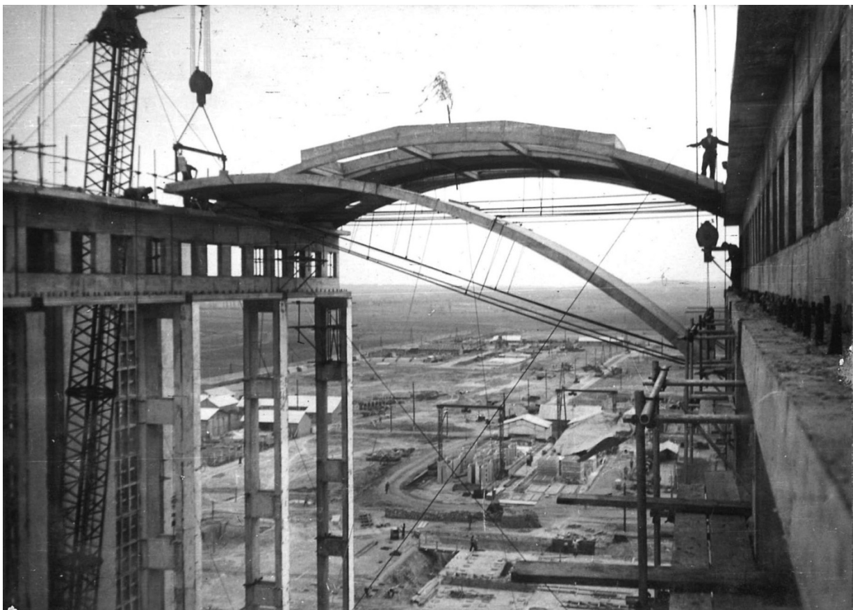
3.kép A kazáncsarnok vonórudas tetőpaneljének elhelyezése No. 2945
