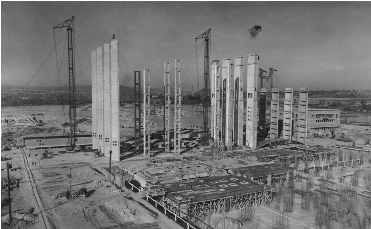
2.kép Építési helyszín a már álló teherhordó homlokzati elemekkel. Jobbra a kisebb belmagasságú turbinacsarnok, a készülő a földémdongával. Balra a négyhajós kazáncsarnok épülő részlete No. 2773
