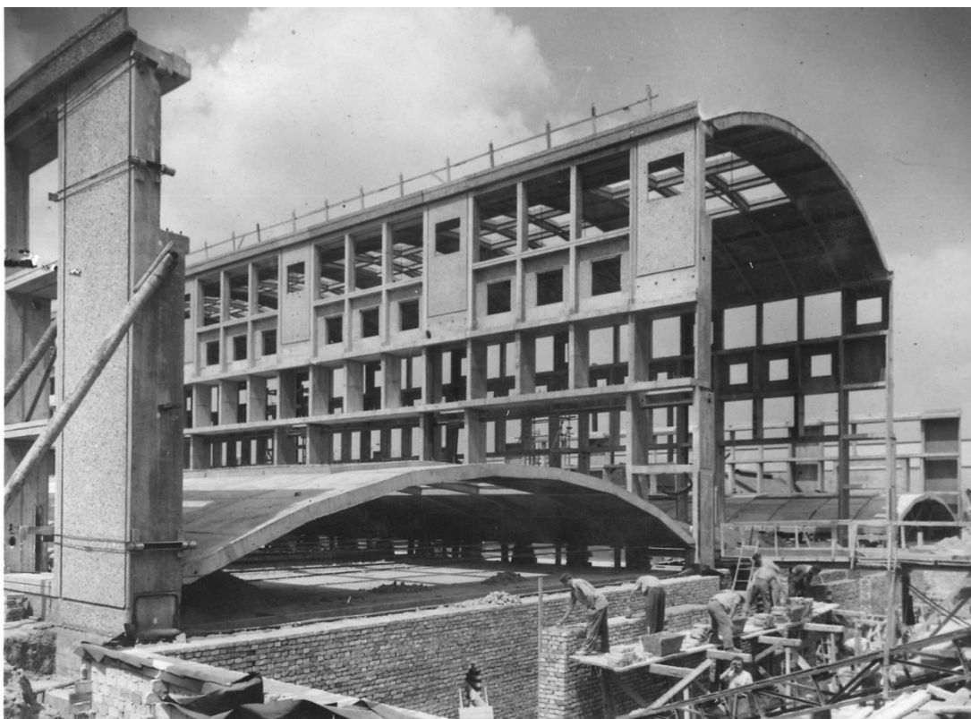
5.kép: IKARUS, a főhajó dongái a helyükön. Jól látható, hogy a falpillérek közé, hasonlóan összetett formájú előregyártott vasbeton ablak és kiváltóelemek kerültek. No. 380
