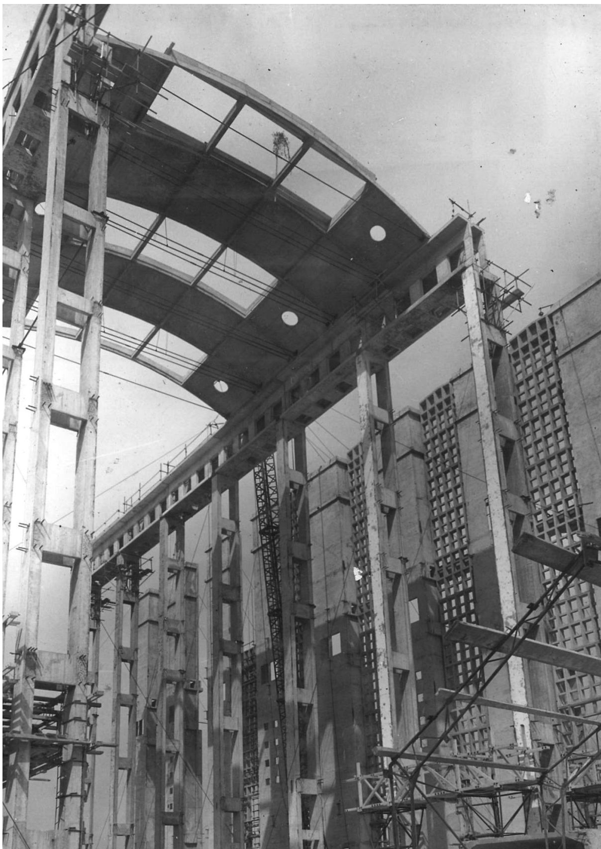
4.kép Az épülő kazáncsarnok. A kiszolgáló sávok közötti hajó között a födémet a homlokzathoz hasonló szerkesztésű bonyolult geometriájú ún. csőpillérek támasztják. A pillérek között szintén áttört, darupályát is tartó gerenda feszül. No. 2951
