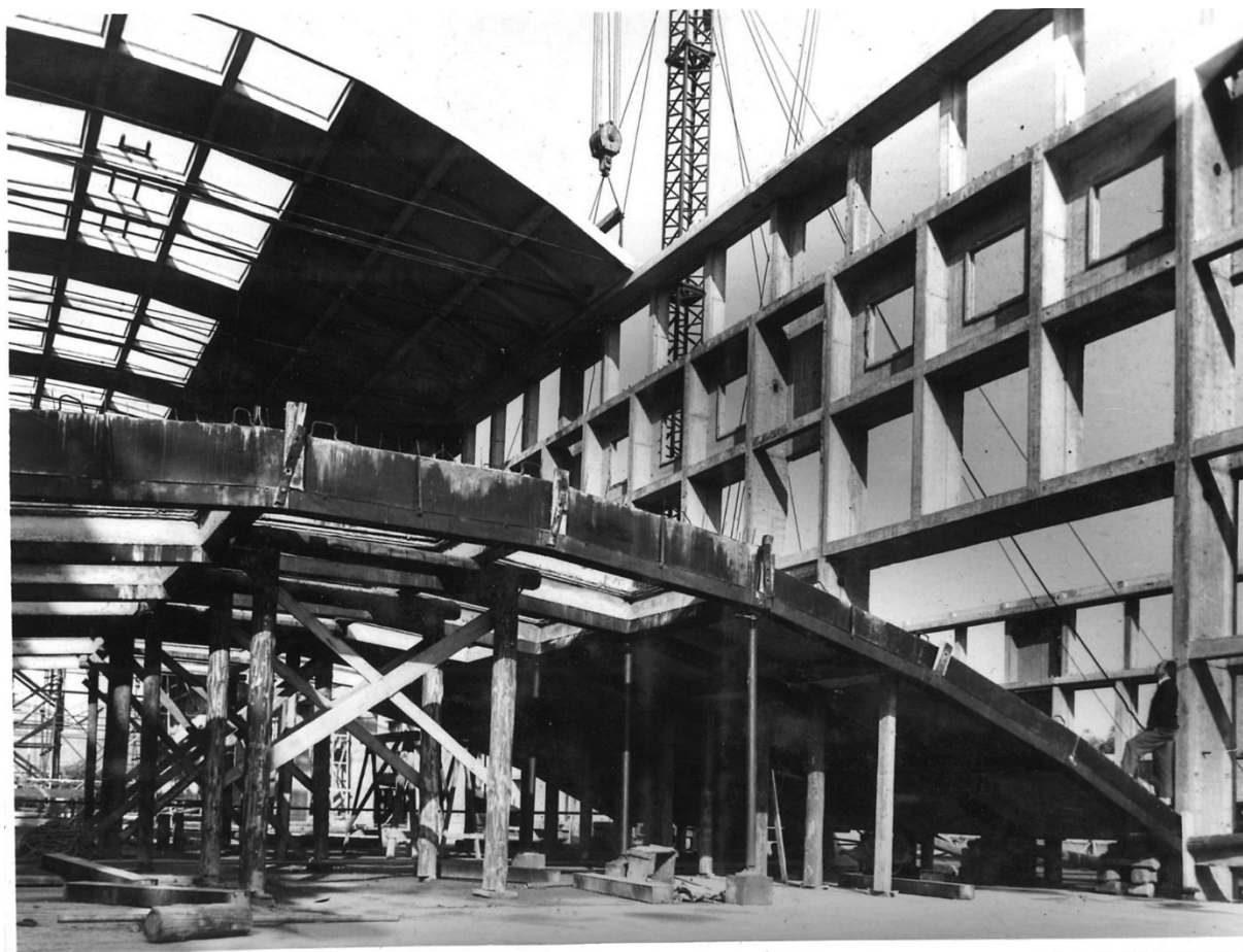
3.kép: IKARUS, a középső hajó vasbeton vonórudas dongaeleme (20,64 m) No. 3419
