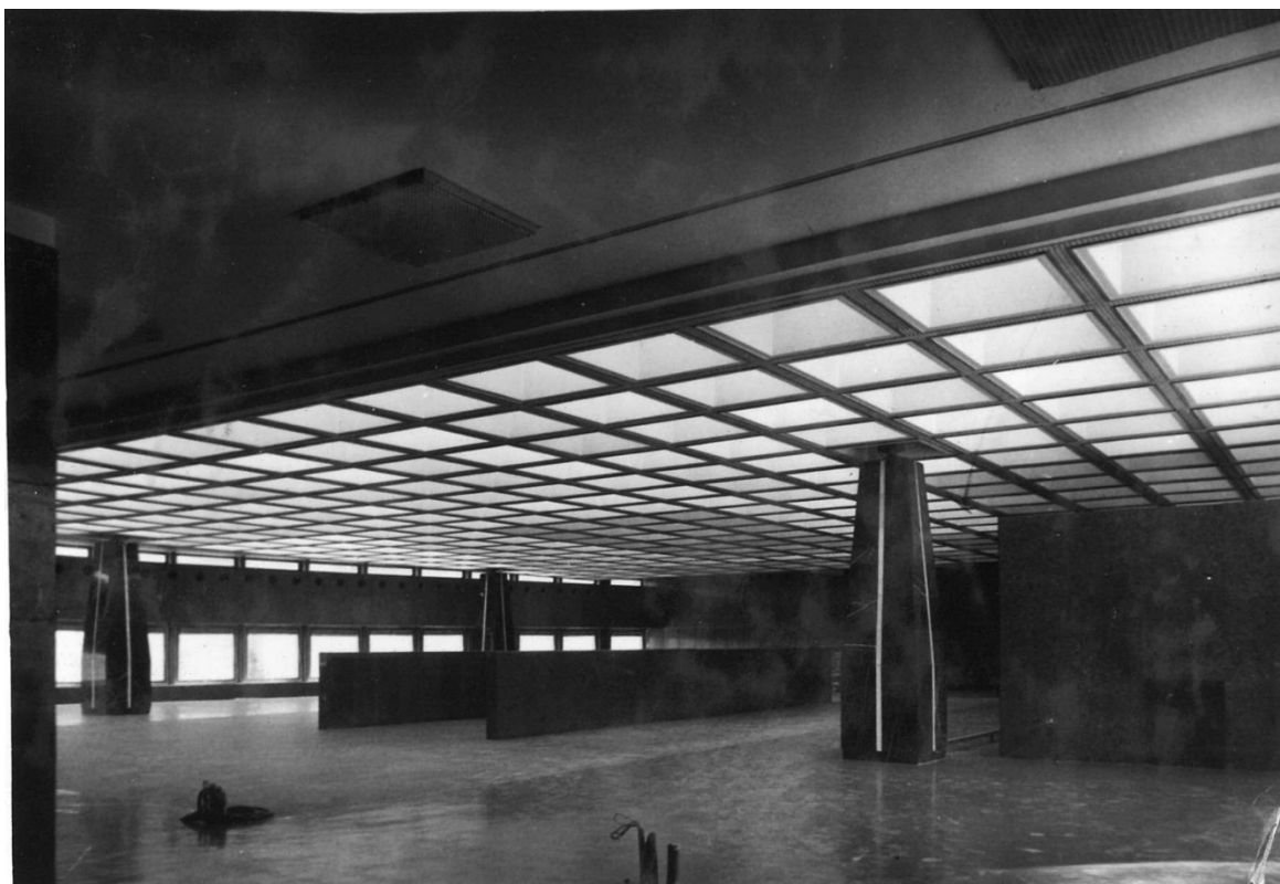
12.kép. az OTP pénztárterem belső képe. Itt a térlefedés négy pillérre támaszkodó kazettarács födém, mezőiben egy-egy felülvilágító.No. 6448
