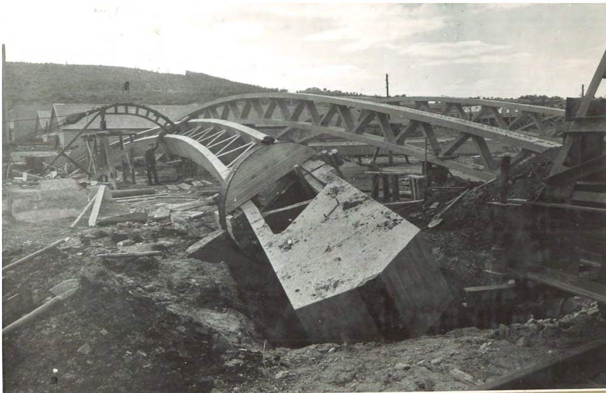
3.kép A főtartók teherviselési irányba történő billentése. A segédstruktúrák felszerelve No. 823
