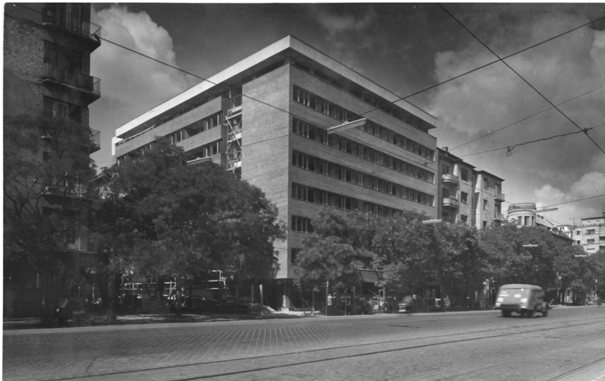
5.kép Budapest XI. kerület Fehérvári út 17. OTP lakóház, Eszék utcai sarok. Gulyás Zoltán építész 1959. A klinkertéglával burkolt épület minősége kimagaslik kortársai közül. MIEA 4460, MÉ 1961/6
