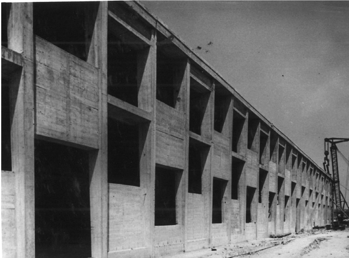
17.kép: Kábelgyár, amíg a főhajó mentén, a mellékrajzok irányába történő szabad átjárás biztosítása érdekében kis alaprajzi kiterjedésű (tömör) pillérek állnak, addig az oldalhajók homlokzatait kazettás beton falpillérek képezik No. 5828
