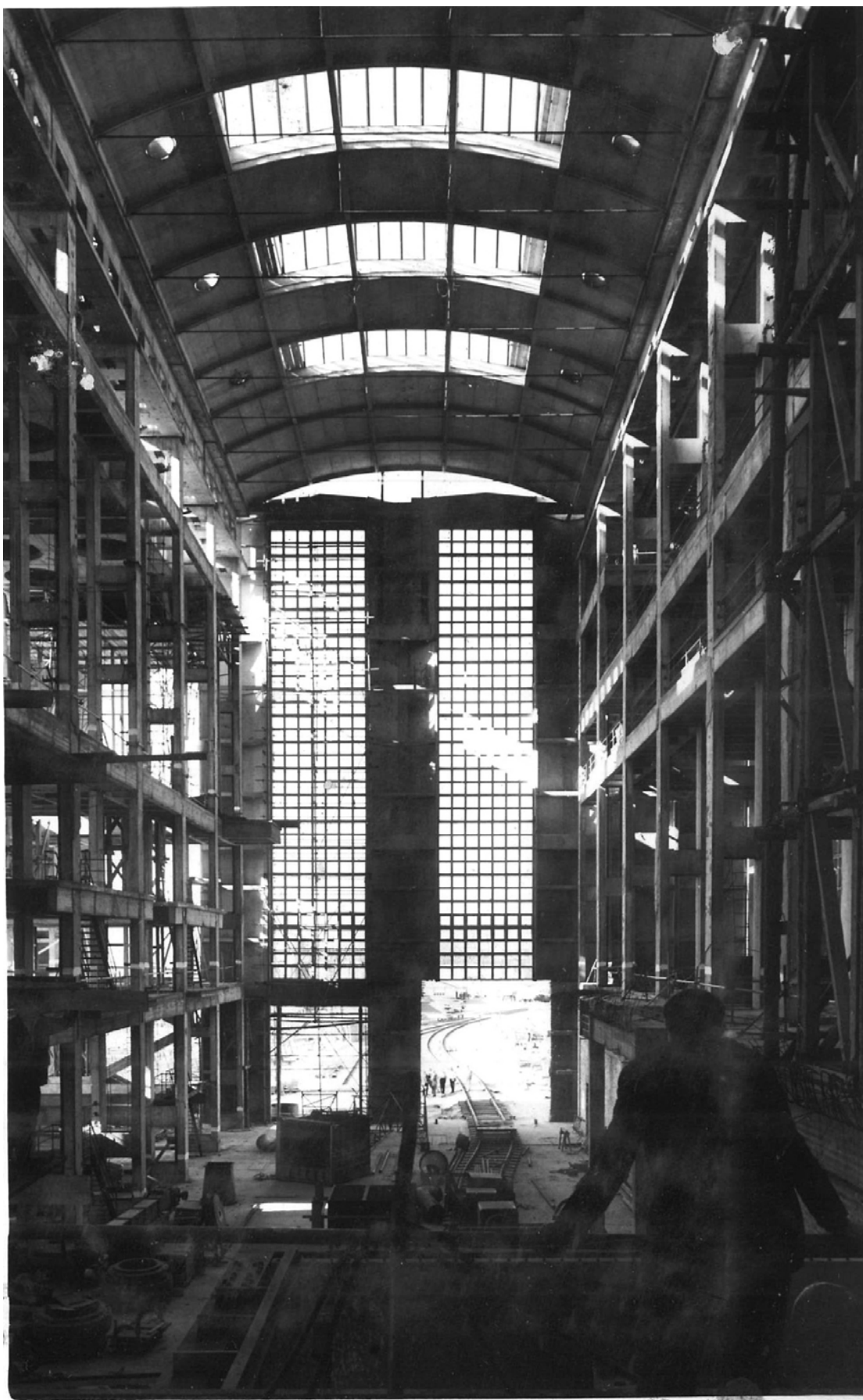
8.kép A kazáncsarnok belső képe, még a technológiai szerelés megkezdése előtt. No. 3385
