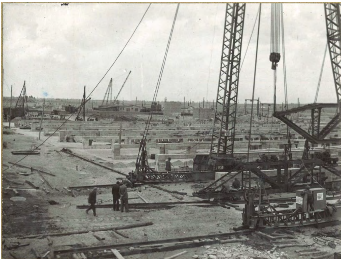
2.kép: A pillérek állításának előkészülete. Az emelés bakdarukkal történik.
