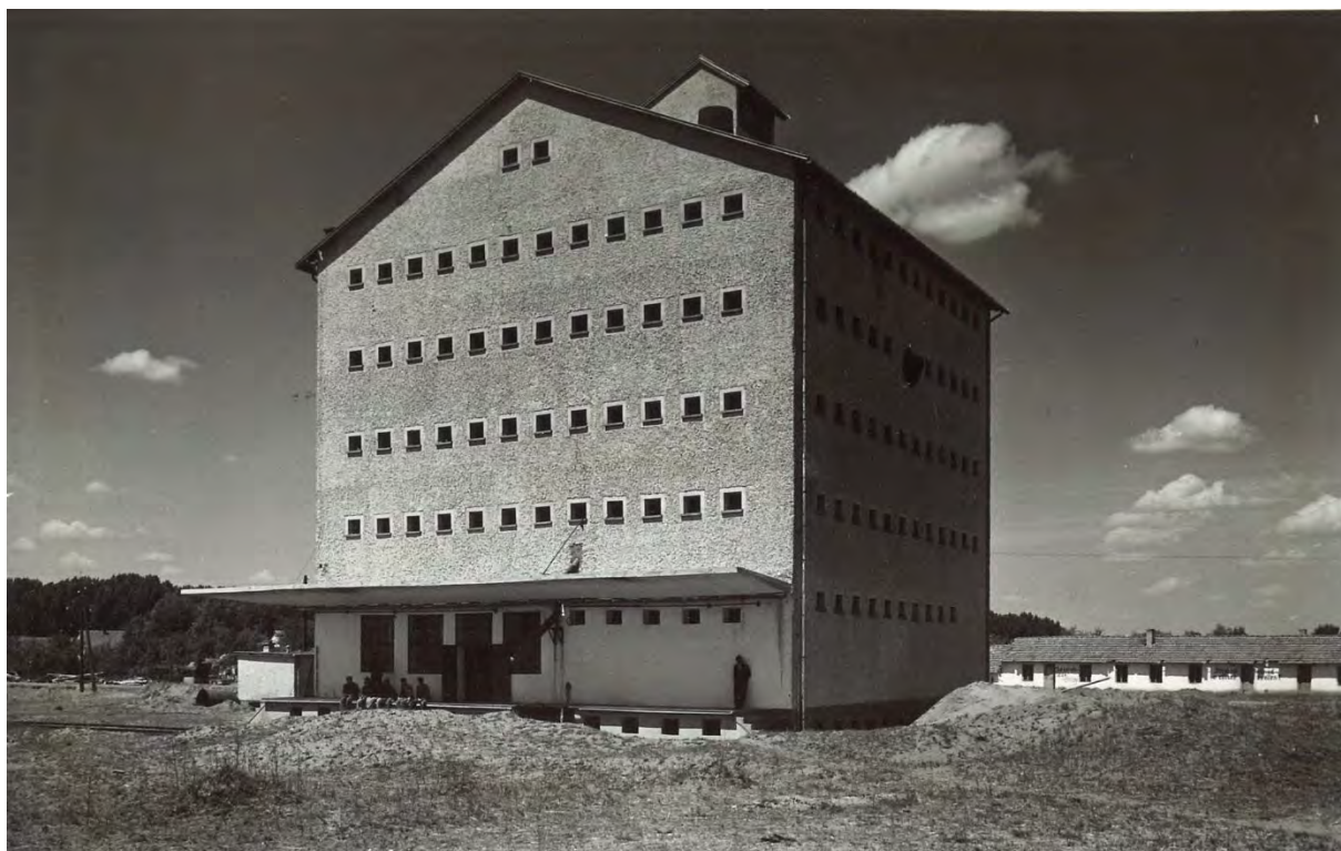
22. kép. Nyírbátor 200 vagonos padozatos tároló, Szabó Árpád, Szontágh Pál. 1955. MIEA mező14_004
