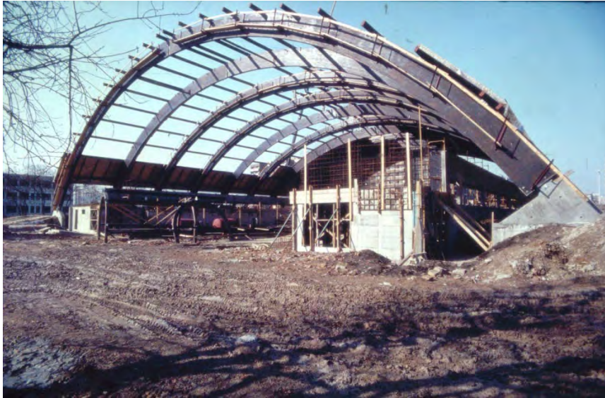
31. kép. Kondorosi úti Uszoda. Építés közben. Jól látható a ragasztott fából készült, hatalmas háromcsuklós keret. MIEA 22602_8_0009
