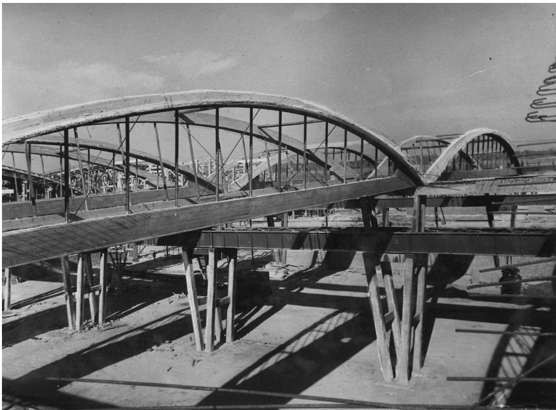
6. kép. Székesfehérvár, Könnyűfémmű Alumínium öntöde és présmű építése. A félkész lefedés. Az íves tartók felső öve között épül majd a befüggesztett héj. MIEA 3864
