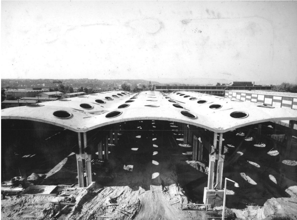
18. Csepel, Csepel Vas- és Fémművek, Szerszámgépgyár építése. A kész szerkezet. MIEA 8836
