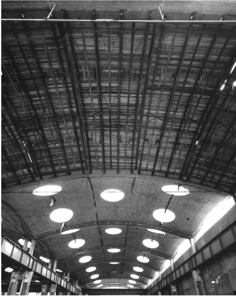
16. Csepel, Csepel Vas- és Fémművek, Szerszámgépgyár építése. Az ívek közé feszülő héjak építése. Az összefüggővé váló (hullámos) felületet lyukasztása biztosítja a csarnok bevilágítását. MIEA 8829
