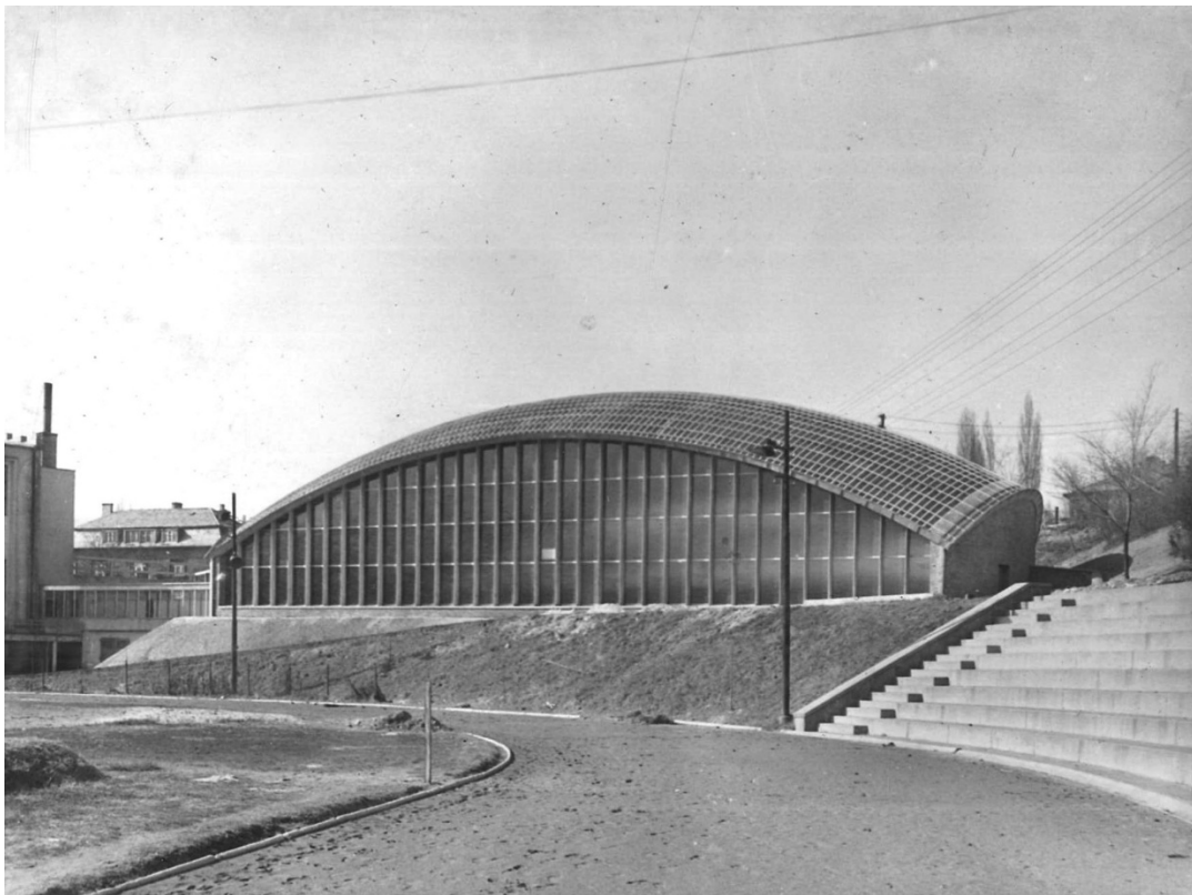
6. kép. Vasas Teniszcsarnok építése. Az elkészült csarnok külső képe. A hullámlemezekre rászerelt keresztirányú alumínium profilok a hég merevítésében játszanak fontos szerepet. MIEA 4136
