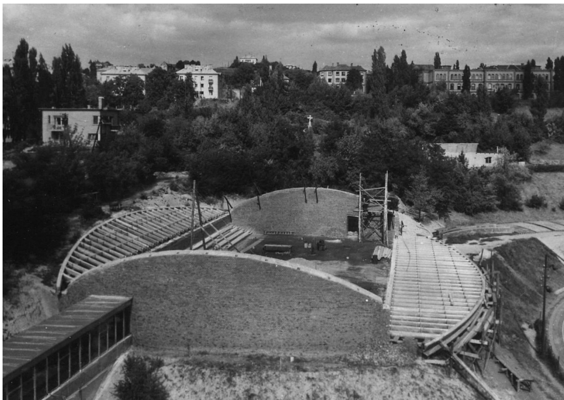
2. kép. Vasas Teniszcsarnok építése. Az íves (önmerevség) és a később felállítandó, a bevilágítást biztosító alumínium üvegfal. MIEA 3911
