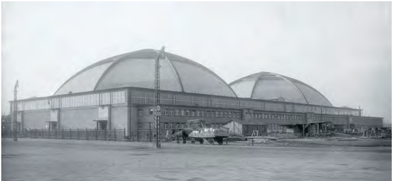
1. kép. Az úttörők munkái ismertek. Kevésbé ismert, de a magyar mérnökség által példának tekintett Franz Dischinger lipcsei nagyvásárcsarnoka. 75méter fesztávolságú, szegmensekből álló kupola. 1930. Forrás: Internet
