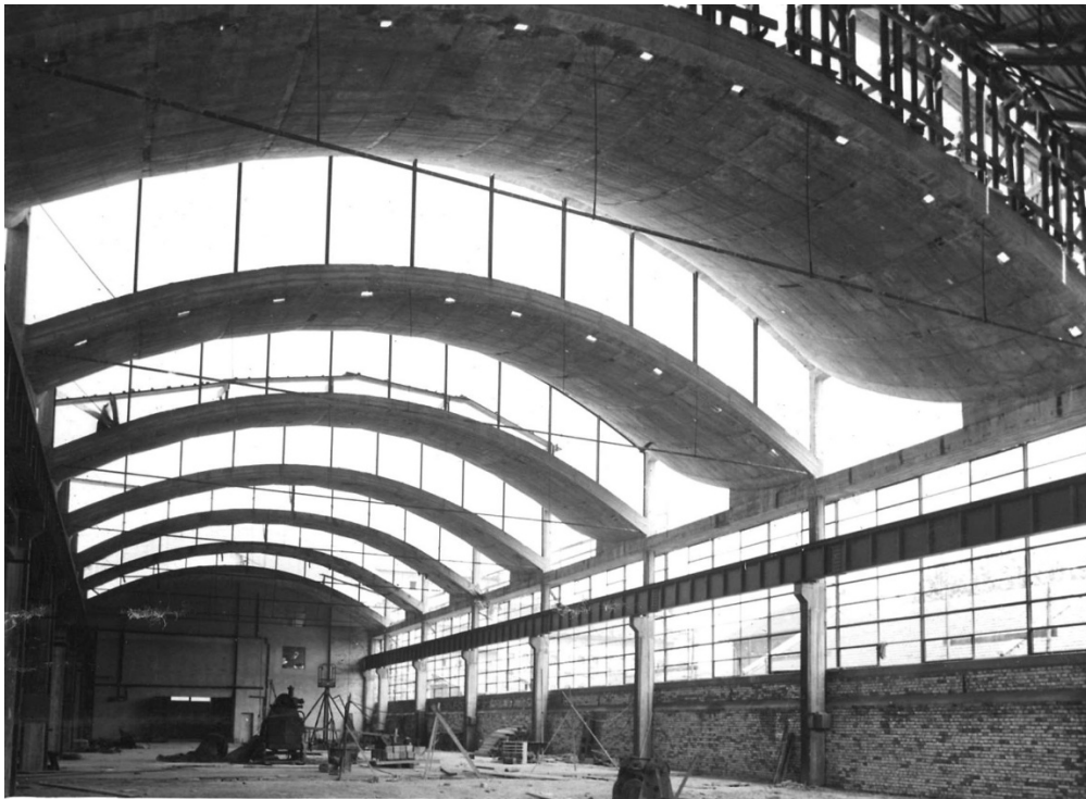
22. kép. Budapest, Ganz-MÁVA, Mozdony és Gépgyár Diesel Hajtóműgyár építése. Az egymás feletti peremgerendák között függőleges felületet képezve feszül a shed-rendszerű bevilágító. MIEA 5724
