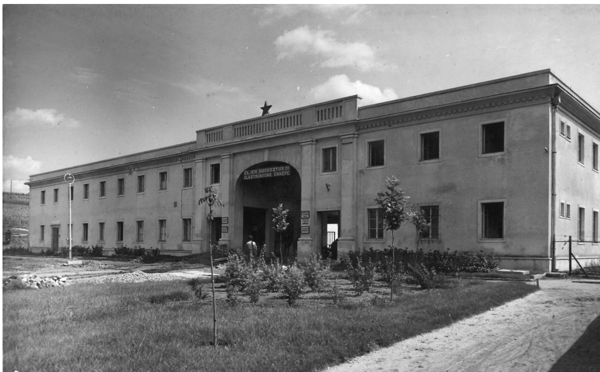
21.kép. Zalaegerszeg Aszfaltgyár bejárati épület MIEA 2412
