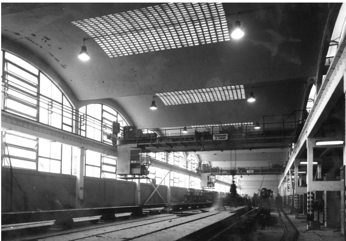
26. kép. Miskolc, Zsolca. Épületelemgyár. Nagy József, Vellay József, Blázi János 1963. Szintén egy egyszerűbb változat. Egyenes gerendák közé feszített dongasorok. A bevilágítás lyukasztott mezők biztosítják. Hosszirányú nézet. MIEA 6930
