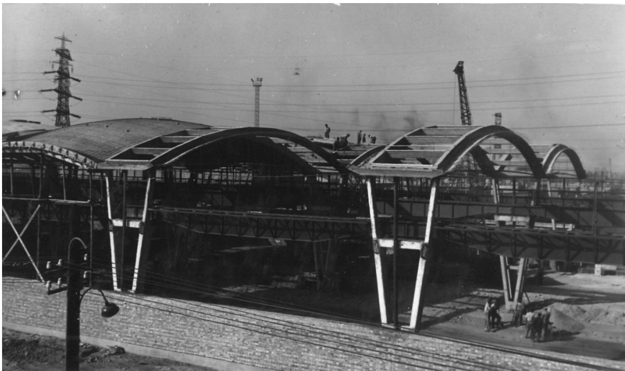
12. kép. Csepel, Csepel Vas- és Fémművek, Csőgyár üzemi csarnok építése. Külső nézet a részben elkészült fedéssel. A dupla íves tartók felső ívére készítik el a tetősíkban fekvő felülvilágító sávot. MIEA 5433
