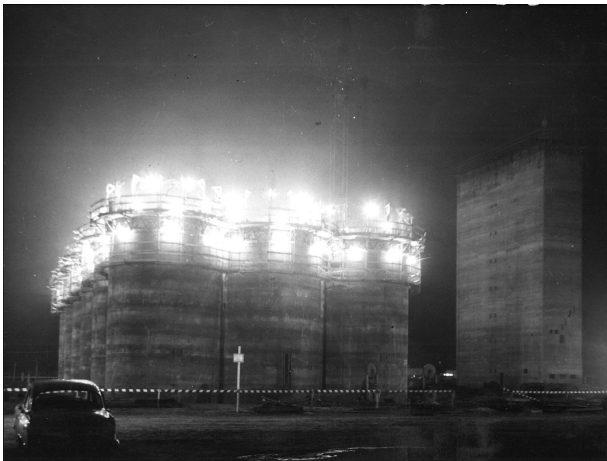
19. kép. A munka éjjel-nappal 7/24 munkarendben folyik. A mátészalkai siló építése.
