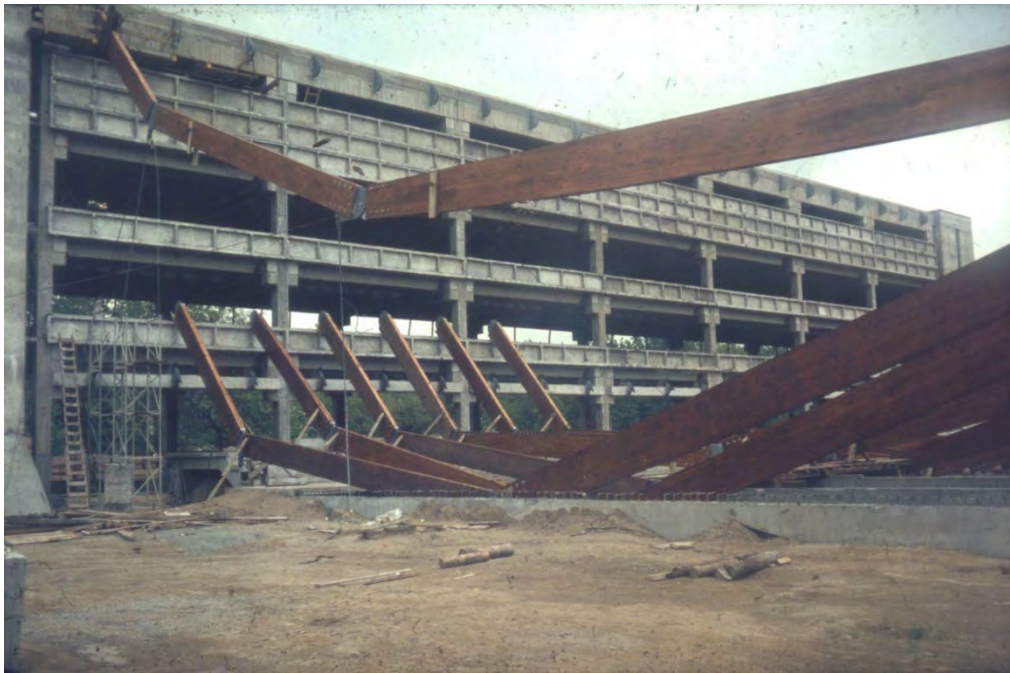
19. kép. Spartacus Uszoda építése. Budapest X. Kőér utca. Építész: Sylvester Ádám, statikus Steinhausz Tibor. A ragasztott fa gerendákból álló rúdlánc főtartó helyére emelése. Balra a masszív többszintes épületszárny, mely az áthidalás lehorgonyzását is biztosítja. MIEA 22601_22805_0004
