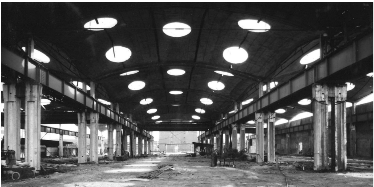
17. Csepel, Csepel Vas- és Fémművek, Szerszámgépgyár építése. Belső kép a technológiai szerelés megkezdése előtt. (a Csőgyárhoz képest finomabb munka feltétlenül igényli az egyenletes és erős mesterséges világítás kiépítését). MIEA 8834
