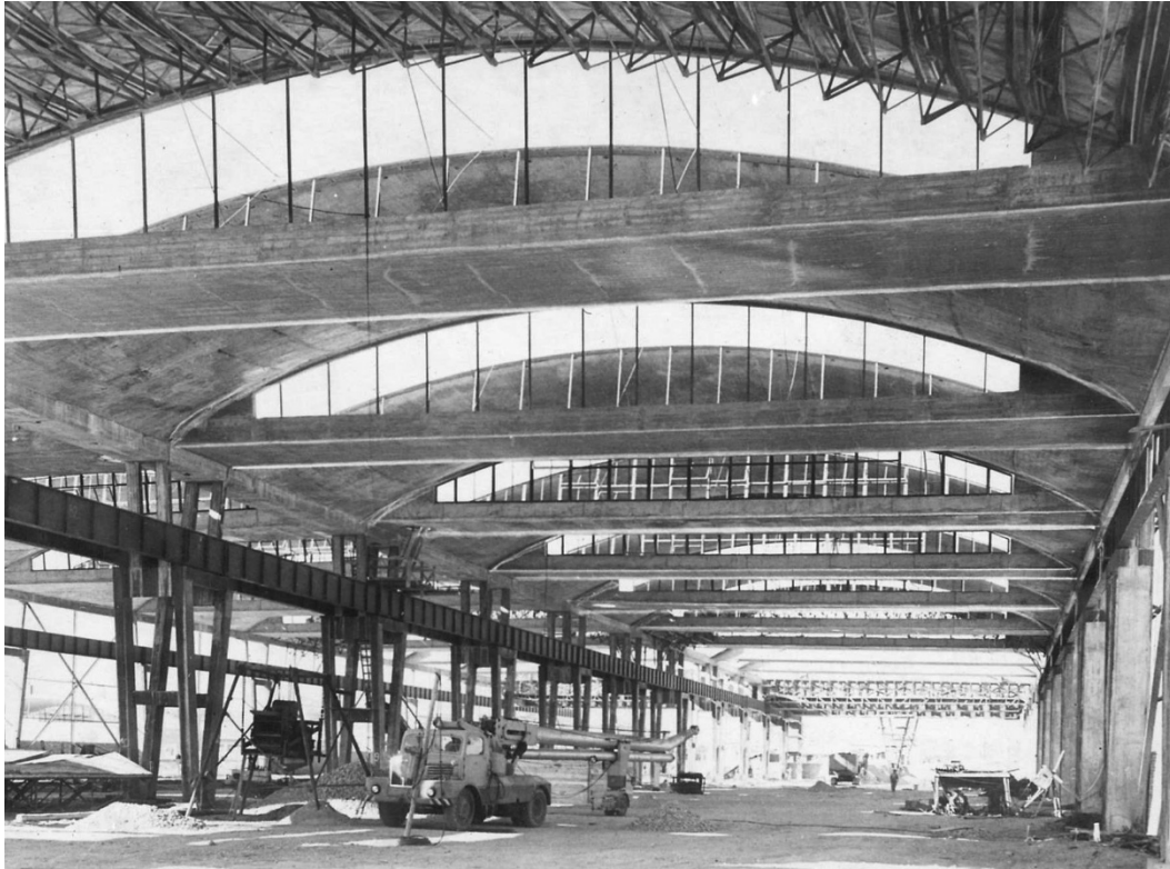
7. kép. Székesfehérvár, Könnyűfémmű Alumínium öntöde és présmű építése. Az íves tartók közé épülnek a héjak. Az utolsó mezőnél látható, hogy az elkészült íves tartókra már csak viszonylag könnyű zsaluzatot kellett építeni. MIEA 3866
