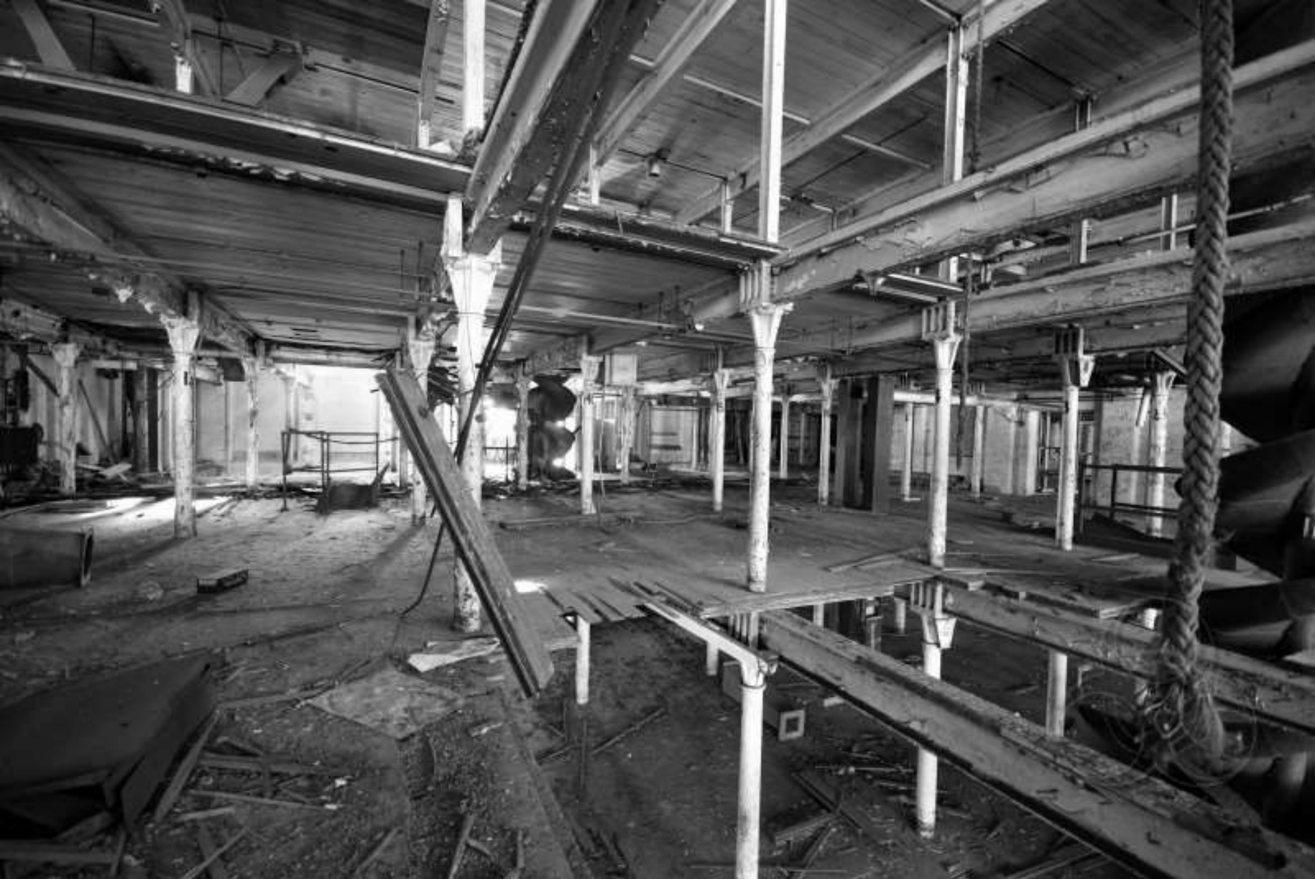
Többszintes üzem jellegzetes belső képe, 1850- öntöttvas oszlopok, öntöttvas gerendák, fafödém, sokablakos téglá homlokzat
