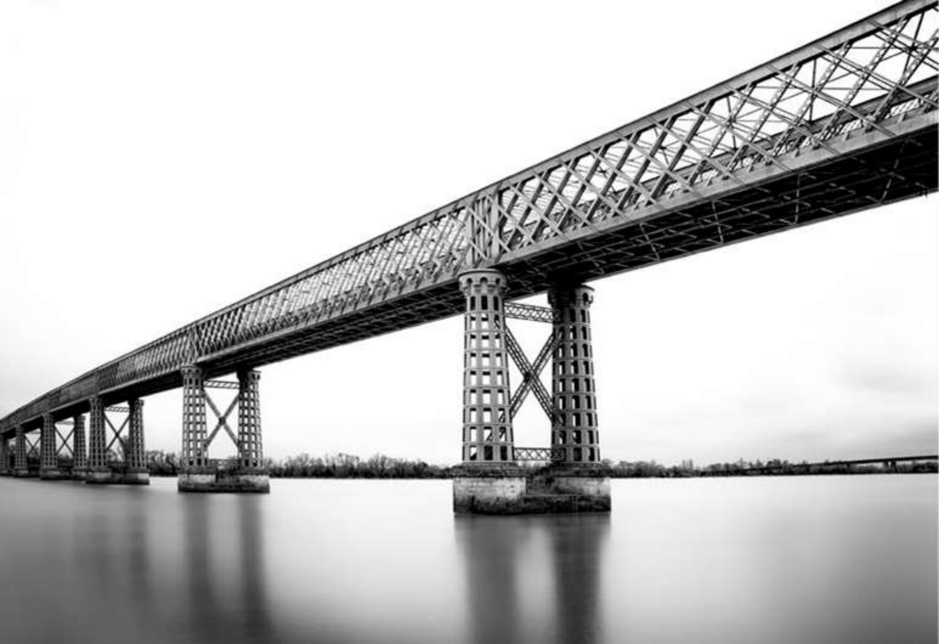
Bordeaux vasúti híd, F, Gustave Eiffel , 1857-1860
