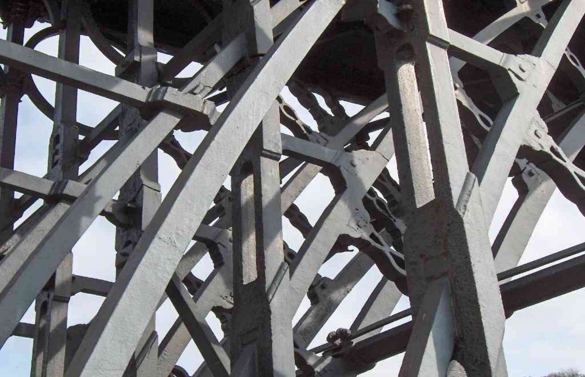
Severn folyó hídja öntöttvas hídja Coalbrookdale közelében, Abraham Darby III. , 1779 -1781 Kapcsolatok: csapolással és ékekkel (mint az ács-, vagy kőszerkezetek esetében)
