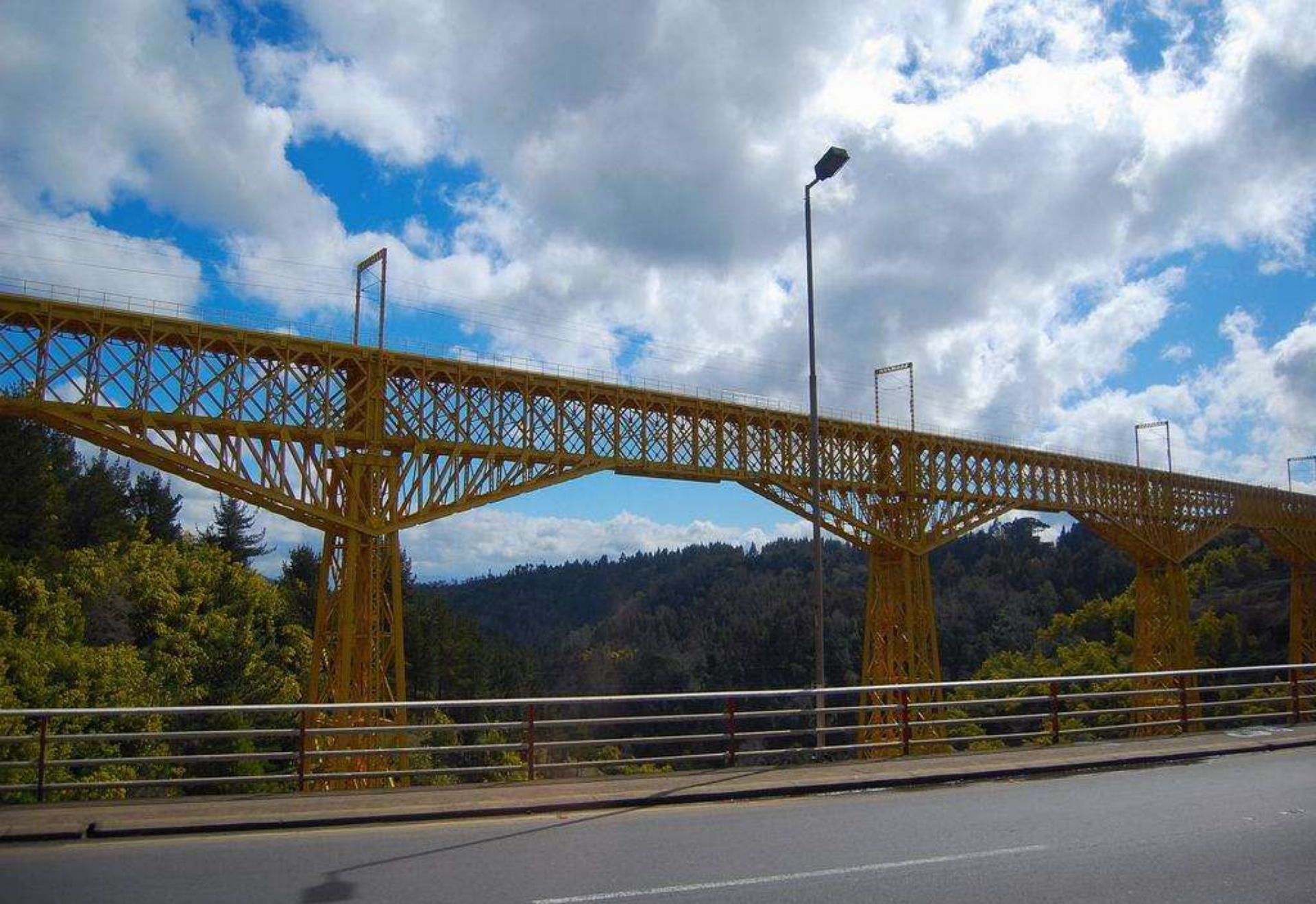
Malleco viadukt, Chile, Gustave Eiffel , 1890
