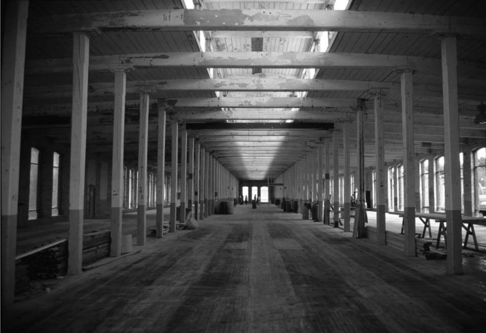
Korai textilgyár felső szintjének belső képe, fa szerkezettel, 1820-50 körül
