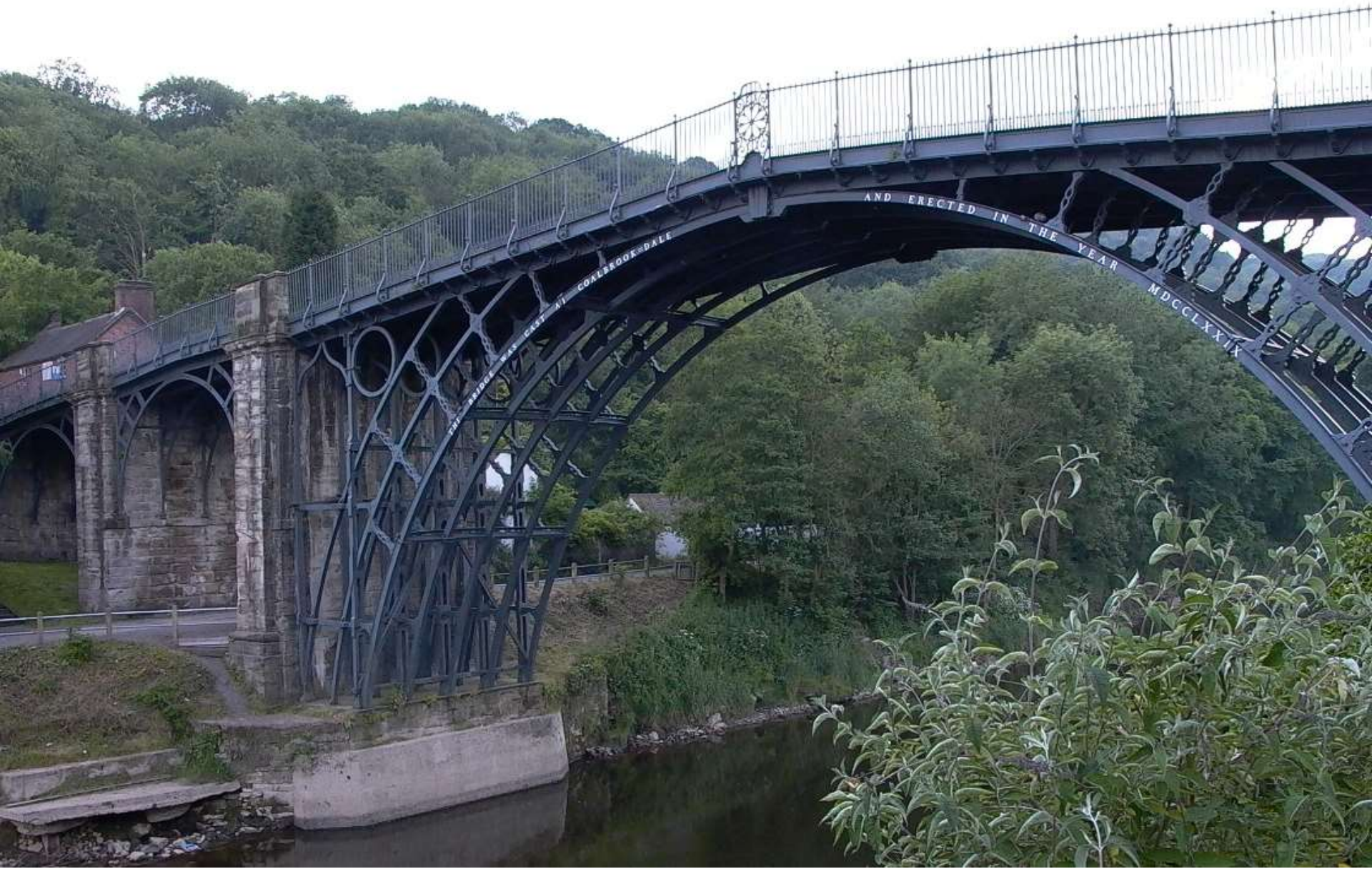
Severn folyó hídja öntöttvas hídja Coalbrookdale közelében, Abraham Darby III. , 1779 -1781 30,6 m fesztáv, 381 tonna öntöttvas
