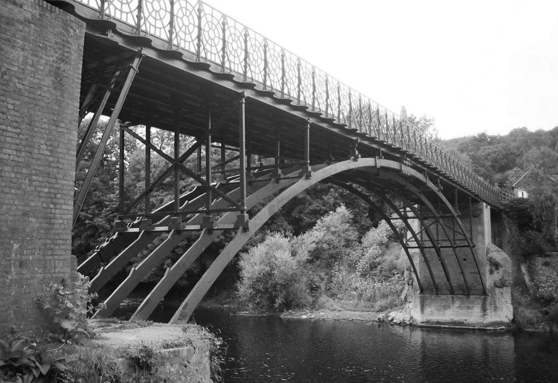
Coalport, 90 m-es vashíd, kavartvas elemekből, Thomas Telford 1818
