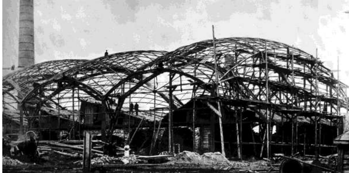
Országos Kiállítás, Nyizsnij Novgorod, Vladimir Shukov, 1897 , kétszeresen acél hajlított rácshéj szerkezet,
