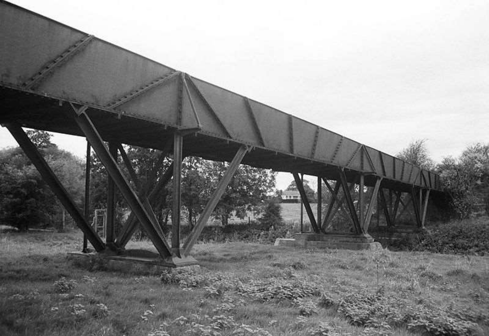
Shrewsbury aquadukt, öntöttvas elemekből: Thomas Telford, 1796
