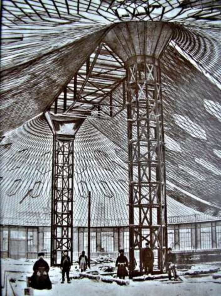
Országos Kiállítás, Nyizsnij Novgorod, Vladimir Shukov, 1896 függesztett acélháló szerkezet
