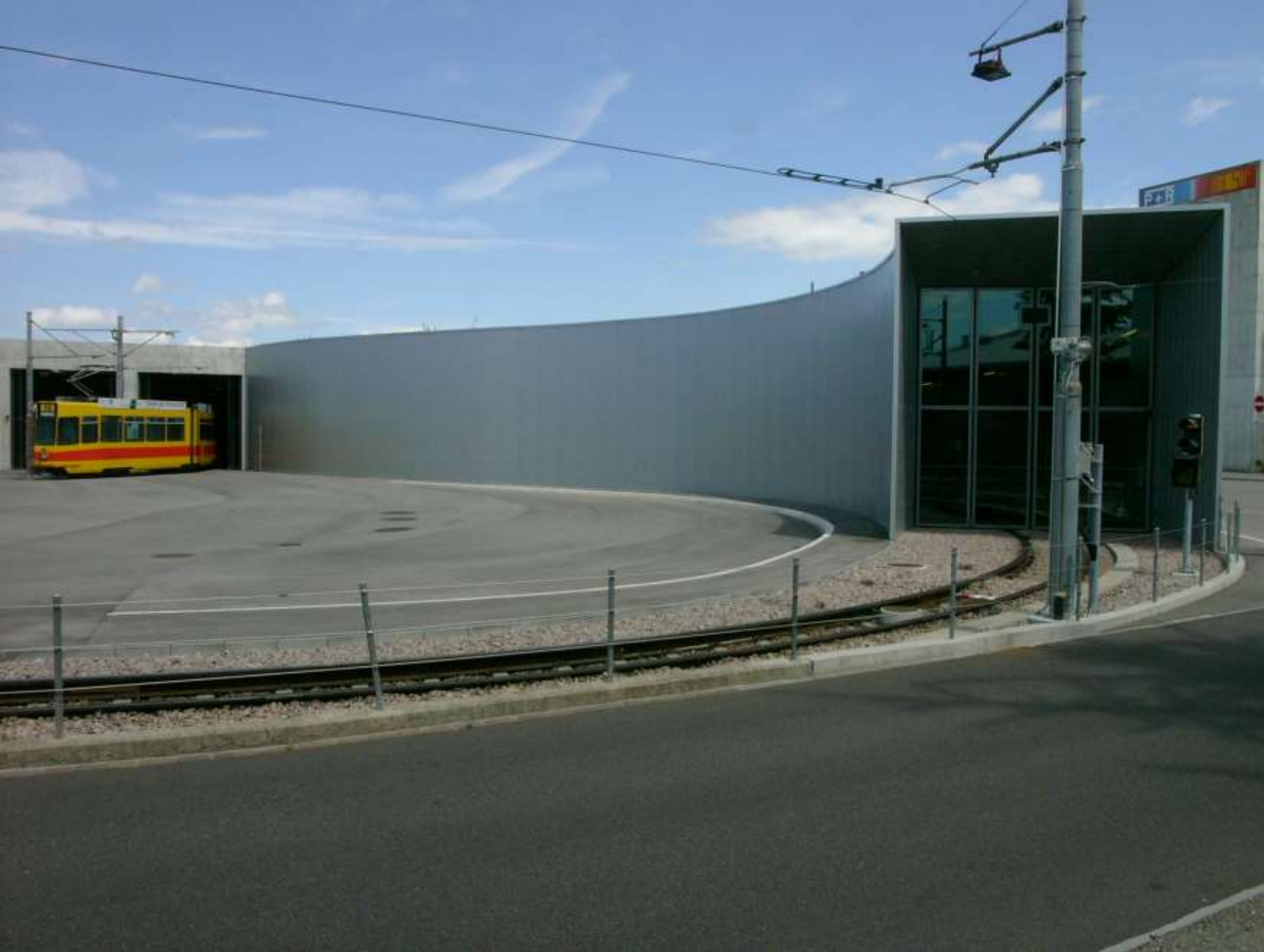
Villamos „remíz” Bázél, Svájc, Proplaning Architecten, 201-2007
