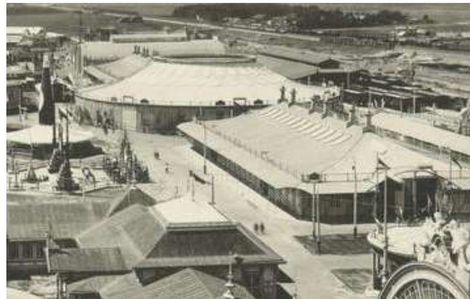
Országos Kiállítás, Nyizsnij Novgorod, Vladimir Shukov, 1897 , kétszeresen acél hajlított rácshéj szerkezet,
