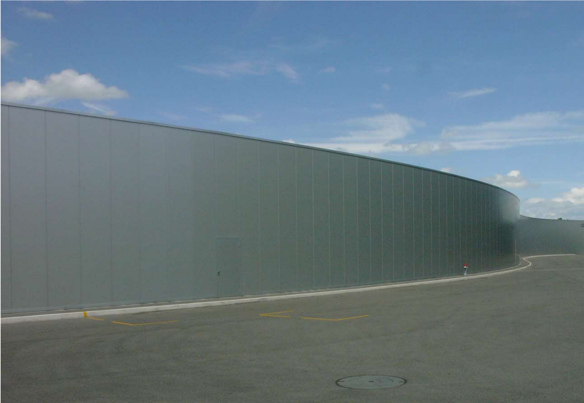
Villamos „remíz” Bázél, Svájc, Proplaning Architecten, 201-2007
