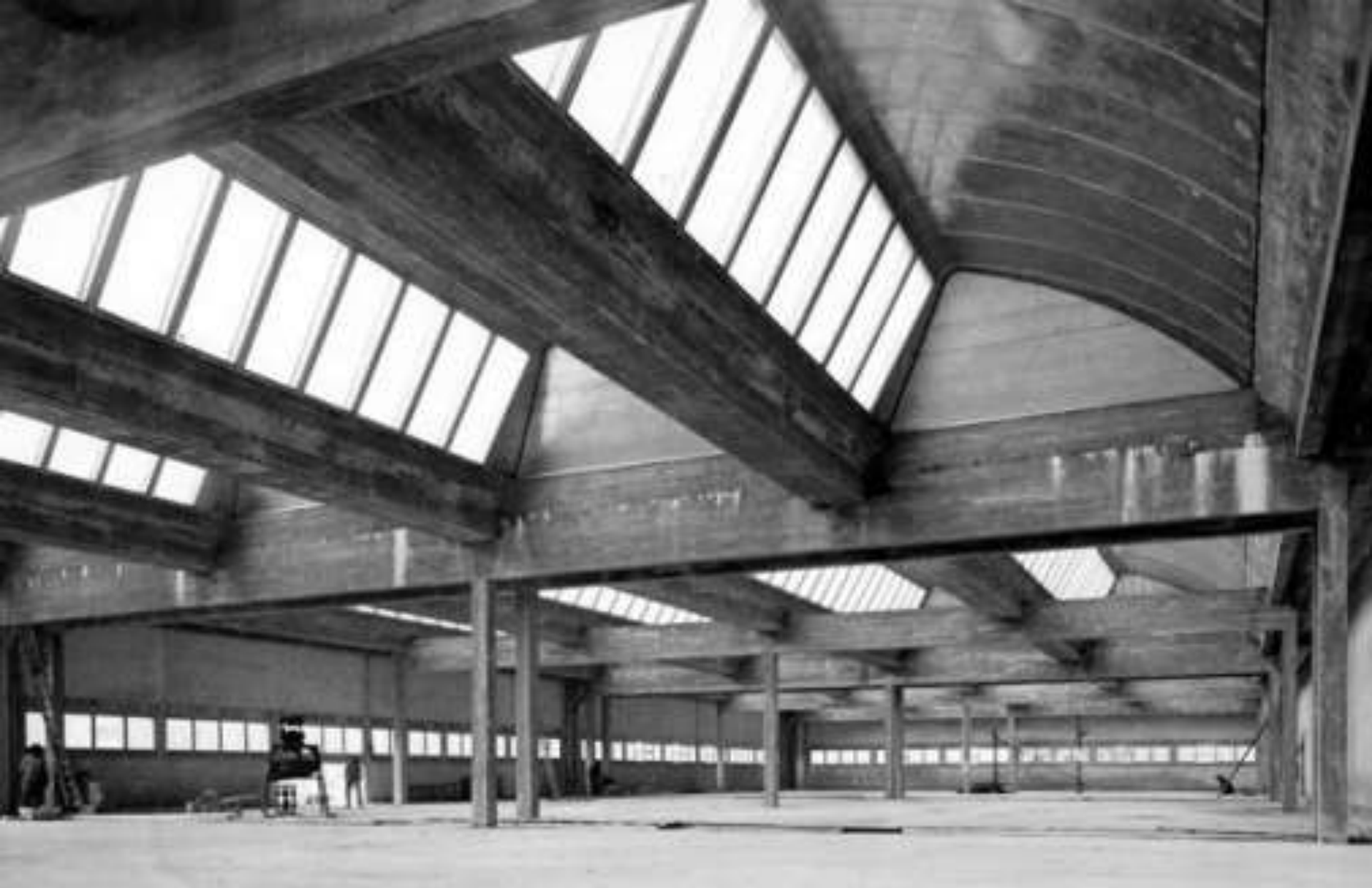
Nyomdacsarnok, Tours, Jean Prouvé, 1950, tájolt shed felülvilágító
