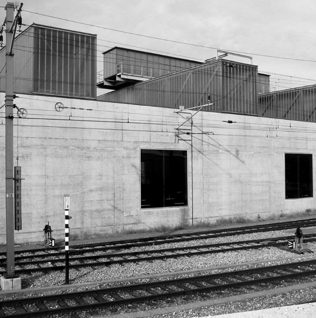
Vasúti javítóépület, Basel, Svájc Herzog & de Meuron, 1995
