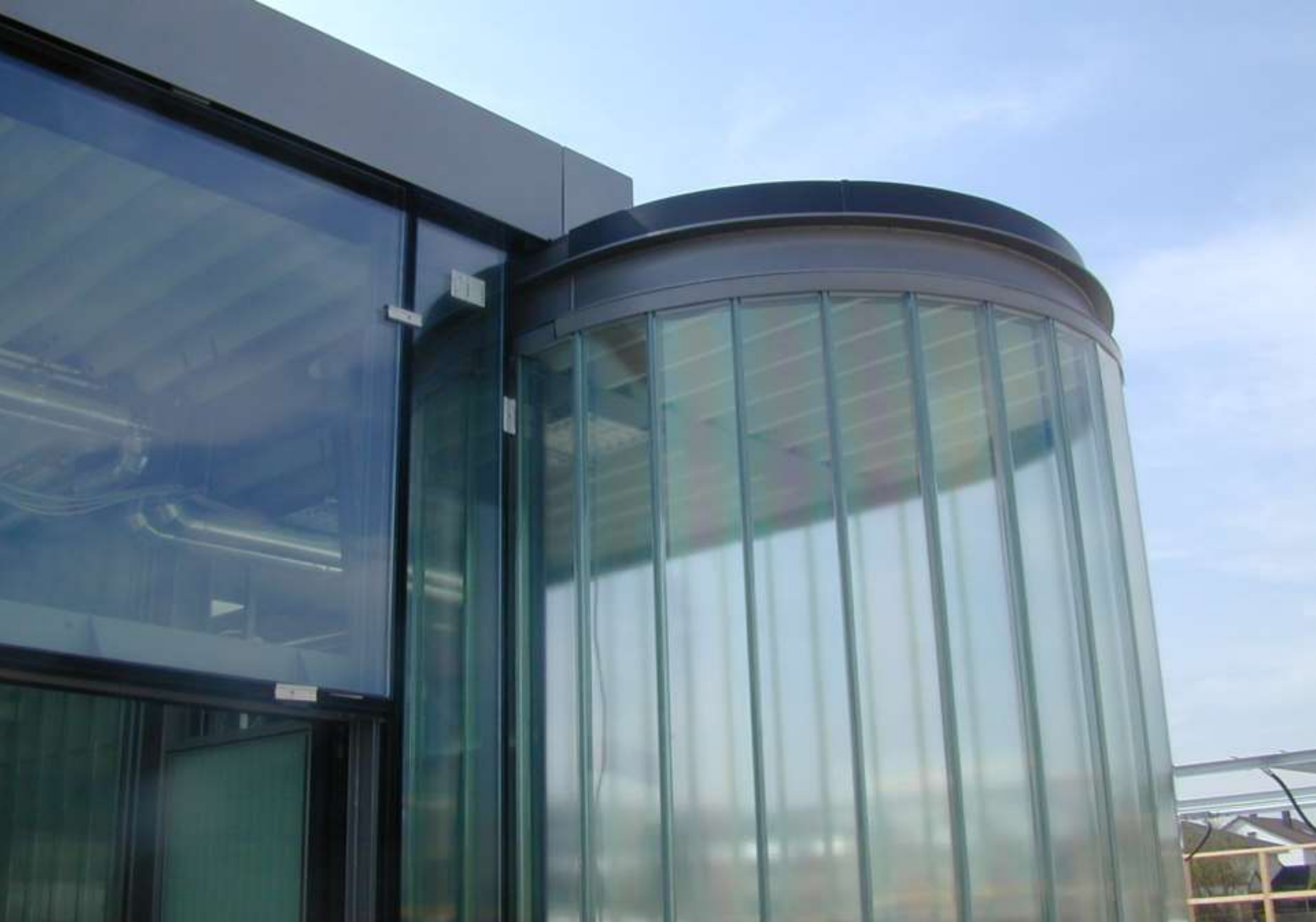
Profilüveg homlokzat részlete
