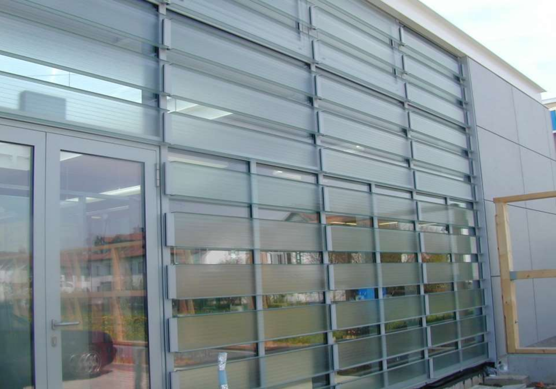
Üveg/Profilüveg homlokzat részlete
