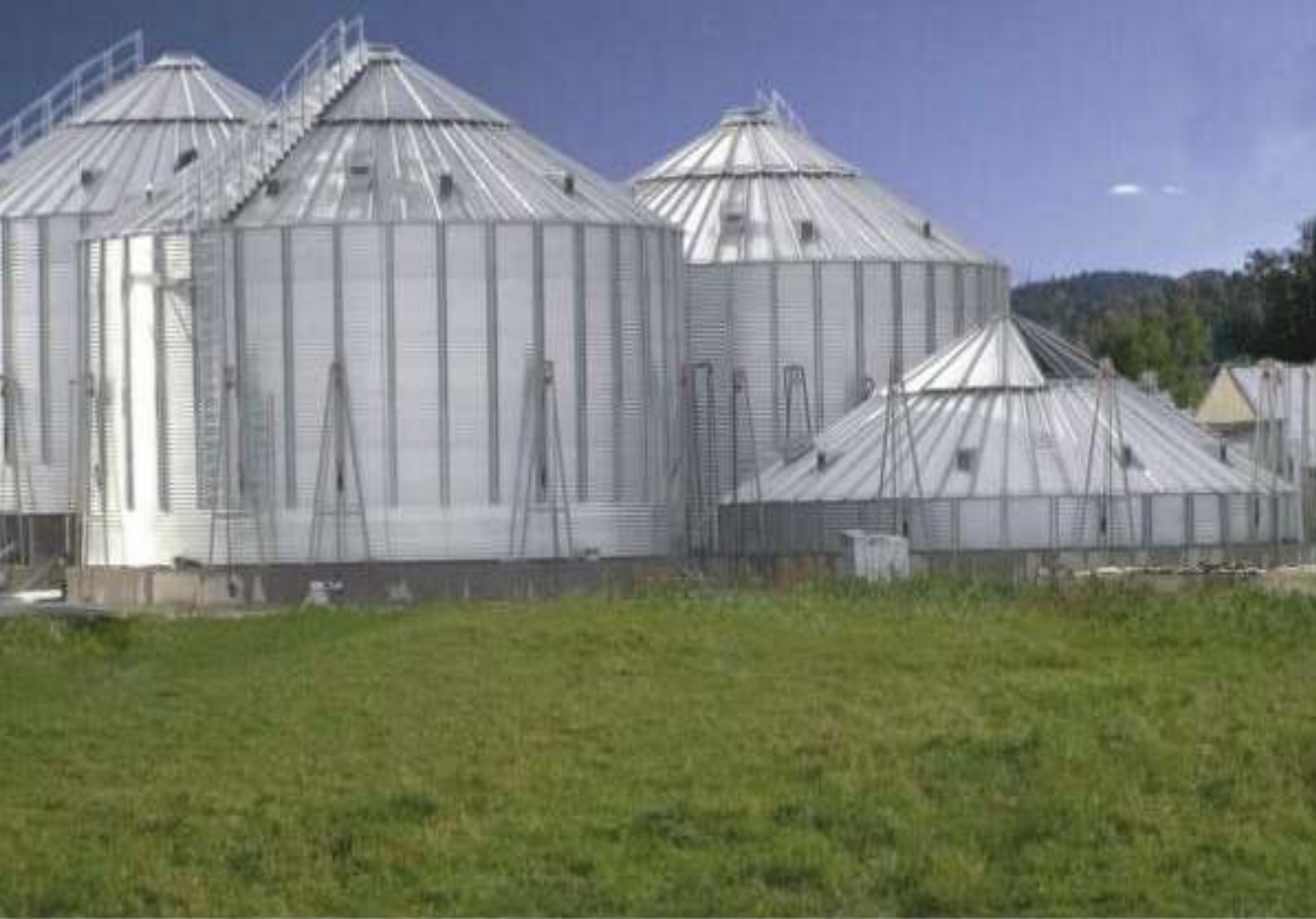
Fémsiló, ömlesztett árú (gabona) raktározására. Építés közben
